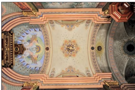
10. Lublin, kościół św. Jakuba – sklepienie prezbiterium po pracach, fot. M. Burzak, 2016
