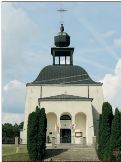
2. Branew, kościół parafialny, fasada po remoncie, fot. od Proboszcza Parafii, 2020
