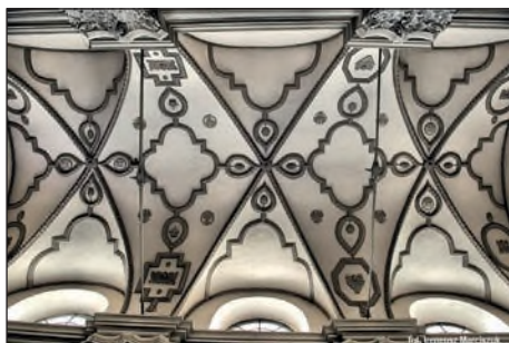
1. Sklepienie bocznej nawy kościoła pw. Św. Ducha w Lublinie, fot. I. Marciszuk, 2017 r.
