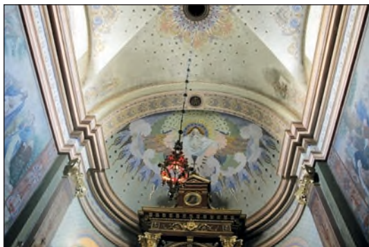
2. Lublin, kościół św. Jakuba – sklepienie prezbiterium przed pracami, fot. M. Burzak, 2015 .
