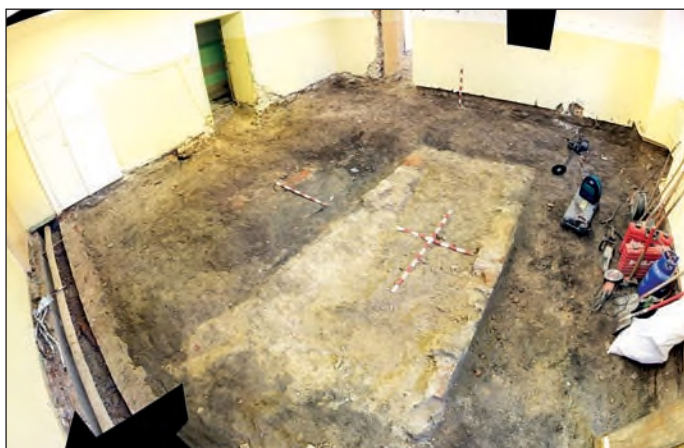
Fot. 8. Widok ogólny na konstrukcję odsłoniętą po środku pomieszczenia nr 8, fot. D. Bednarski
