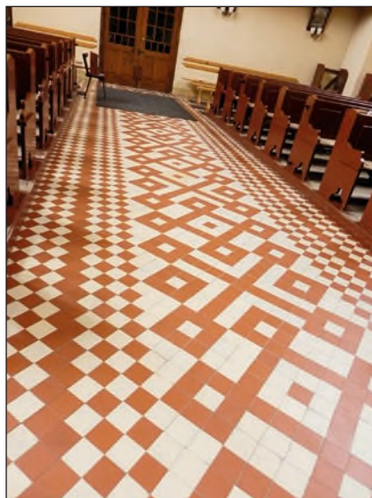
4. Branew, kościół parafialny, środkowy pas posadzki przed remontem, fot. A. Wiśniewska, 2016
