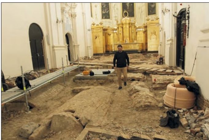
9. Krypty K4-K6 odsłonięte w trakcie prace remontowych z nadzorującym prace Przeorem.
