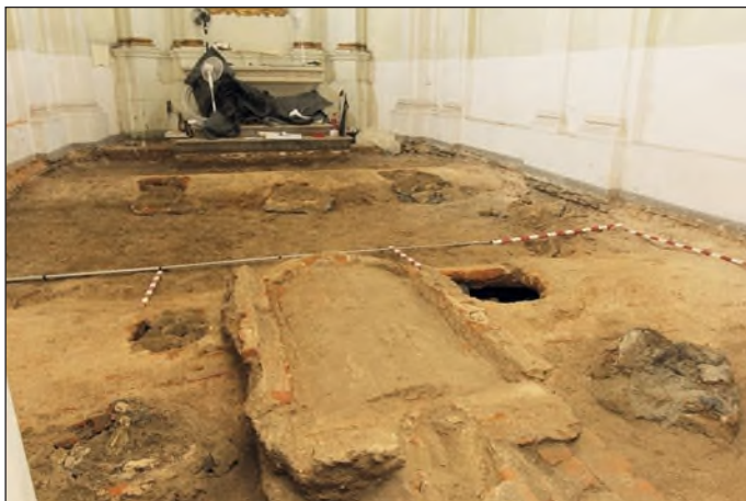
7. Odsłonięte sklepienia krypt w kaplicy Paryskiej podczas prac remontowych.
