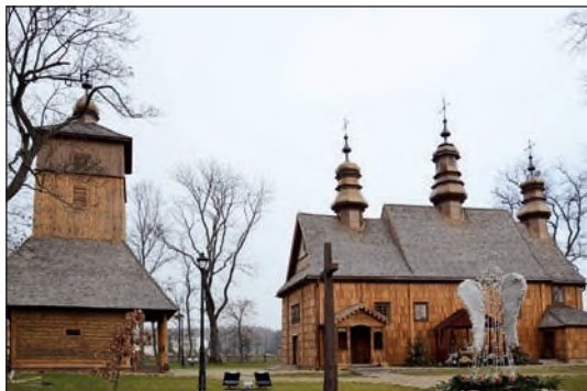
1. Hanna, widok na kościół i dzwonnice po pracach, fot. A. Frąckiewicz, 2020
