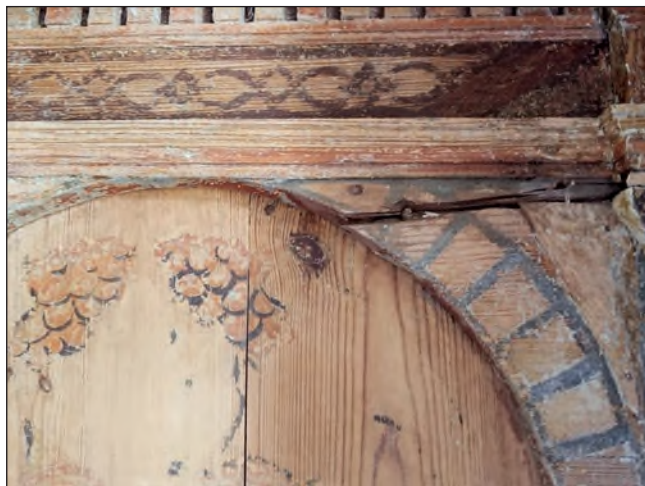
18. Fragment płyciny balustrady po usunięciu przemalowań, fot. M. Filip, 2018
