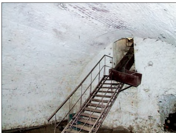
Fot. 3. Wnętrze i zejście do piwnicy znajdującej się pod salą nr 2, fot. D. Bednarski
