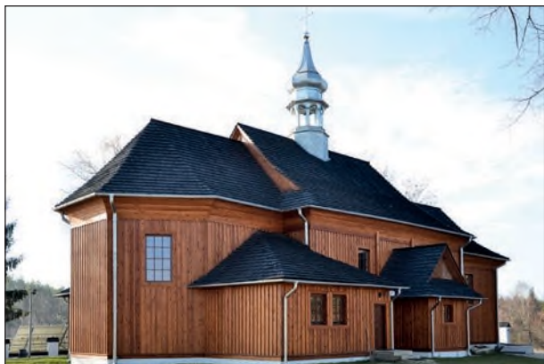
12. Łosiniec, apsyda i elewacja boczna kościoła po remoncie, fot. A. Frąckiewicz, 2020
