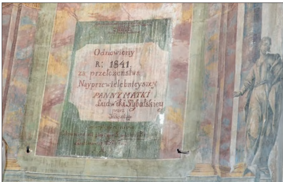
7. Napis dokumentujący część prac renowacyjnych prowadzonych w kościele św. Piotra Apostoła w Lublinie, fot. K. Tur-Marciszuk, 2019
