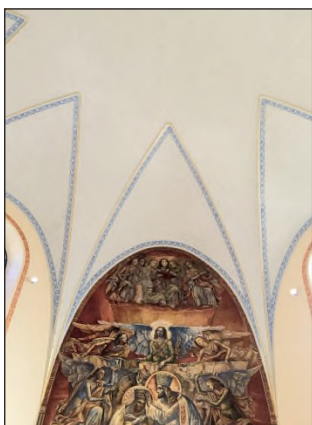
18. Kościół w Zagłobie, ściana ołtarzowa prezbiterium po konserwacji, fot. K. Stępień, 2019
