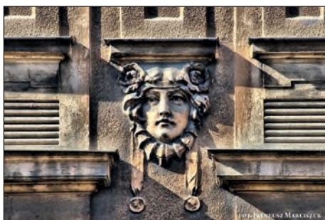
2. Dekoracja architektoniczna kamienicy przy ul. Narutowicza 47 w Lublinie, fot. I. Marciszuk, 2019 r.
