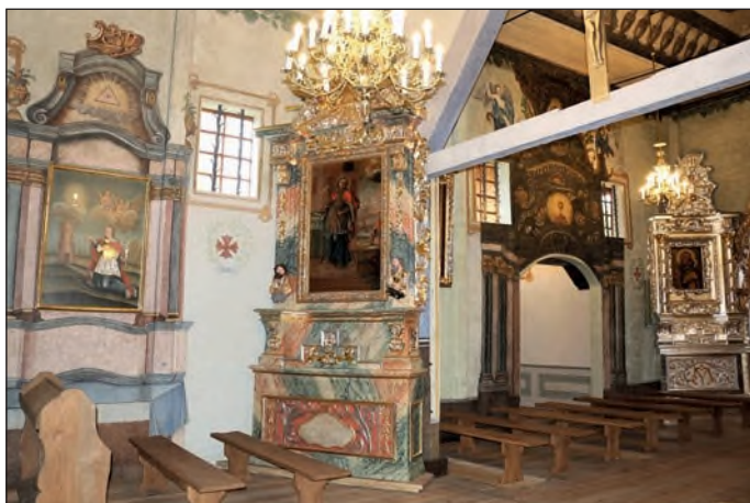
10. Hanna, kościół – wnętrze po pracach, fot. P. Wira, 2019
