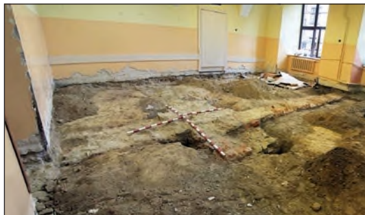
Fot. 6. Ogólny widok od zachodu na konstrukcje murowane odsłonięte w pomieszczeniu nr 7, fot. D. Bednarski
