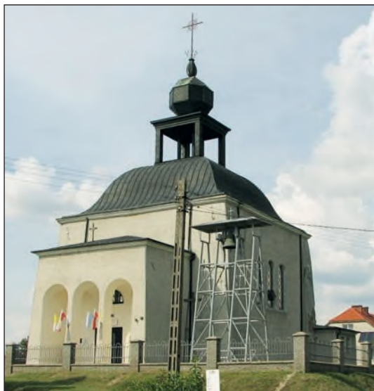
3. Branew, kościół parafialny, elewacje po remoncie, fot. od Proboszcza Parafii, 2020
