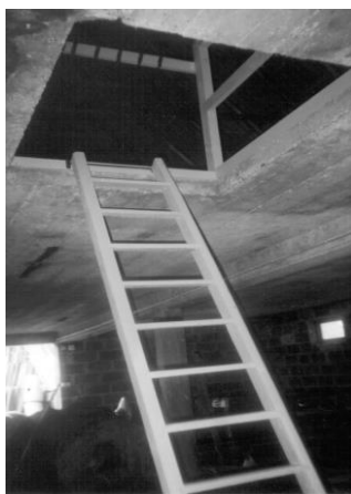
Drabina i zabezpieczenie otworu zrzutowego wykonane w ramach konkursu na wykonanie zaleceń prewencyjnych. fot. OR w Białymstoku
