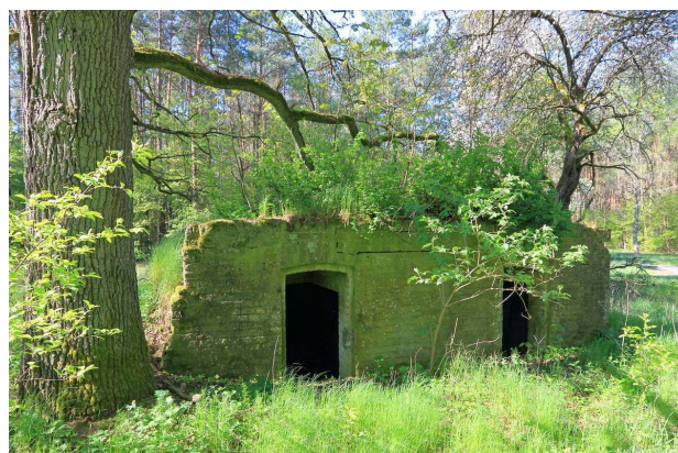
Fotografia 14. Piwnica w nieistniejącej osadzie służbowej Oporów (Gaffel), leśnictwo Mąkowary, oddział 207
