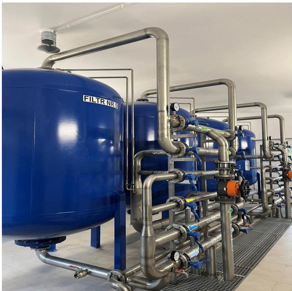
Zdjęcie 1. Nowa hala filtrów w Stacji Uzdalniania Wody w Pysznicy
