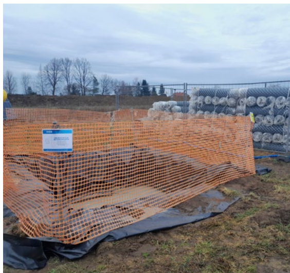
Przykład organizacji miejsca do mycia betonowozów
