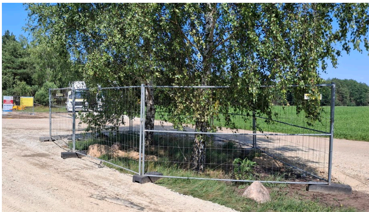
Ostony przypniowe drzew na budowie na przykładzie „Remontu ul. Chodkiewicza w Kołobrzegu” oraz „PV Serby”
