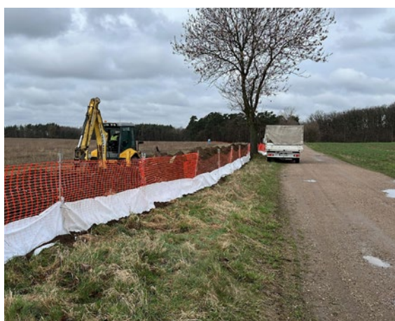
Zastosowanie wygradzeń na budowie PV Grabin
