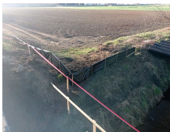
Zastosowanie wygradzeń na budowie farmy wiatrowej Miejska Górka
