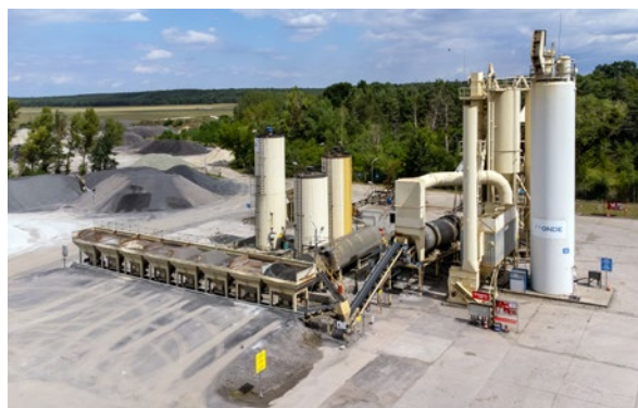
Wytwórnia Mas Bitumicznych ONDE S.A. w Toruniu
