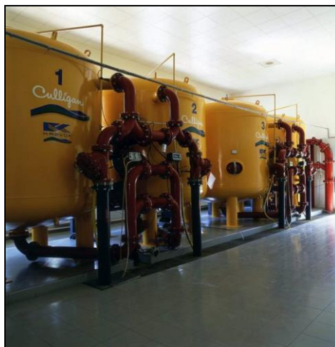
Stacja uzdatniania wody „Centralna”
