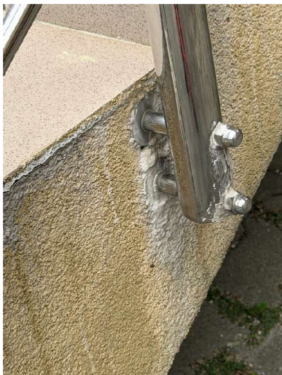
Zdj. nr 10 i 11 – widok „zabrudzonego” mocowania balustrady do płyty balkony i policzków schodów
