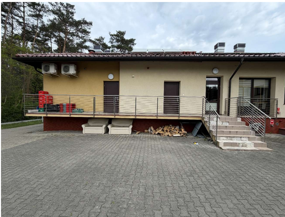
Zdj. nr 1 – widok ogólny na balkon wraz ze schodami
