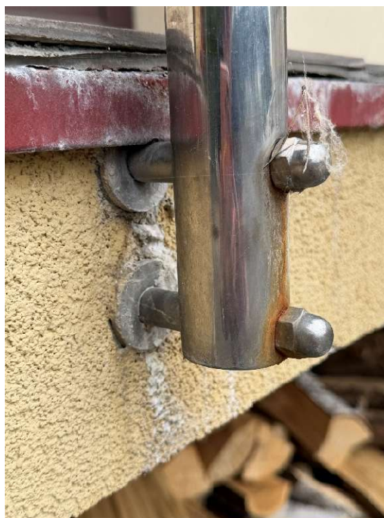
Zdj. nr 10 i 11 – widok „zabrudzonego” mocowania balustrady do płyty balkony i policzków schodów
