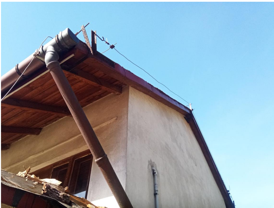
Fot.3. Fragment orynnowania oraz instalacji odgromowej.
