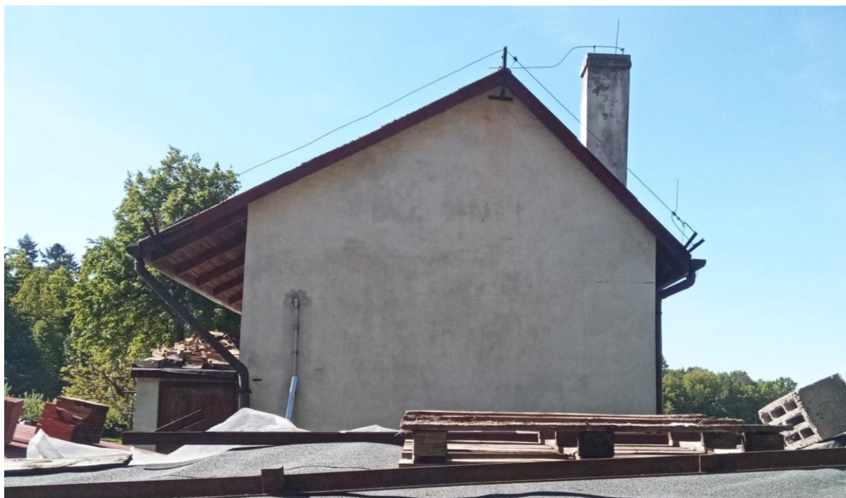
Fot.2. Elewacja północna.
