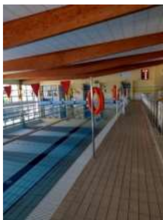
Zdjęcie 11. Kryta pływalnia „Hydrosfera” w Kietrzu
