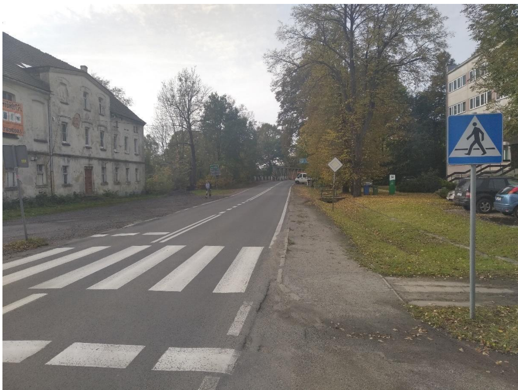
Dojście do budynku od przejścia dla pieszych przez drogę wojewódzką nr 364 Lwówek Śląski - Gryfów Śląski
