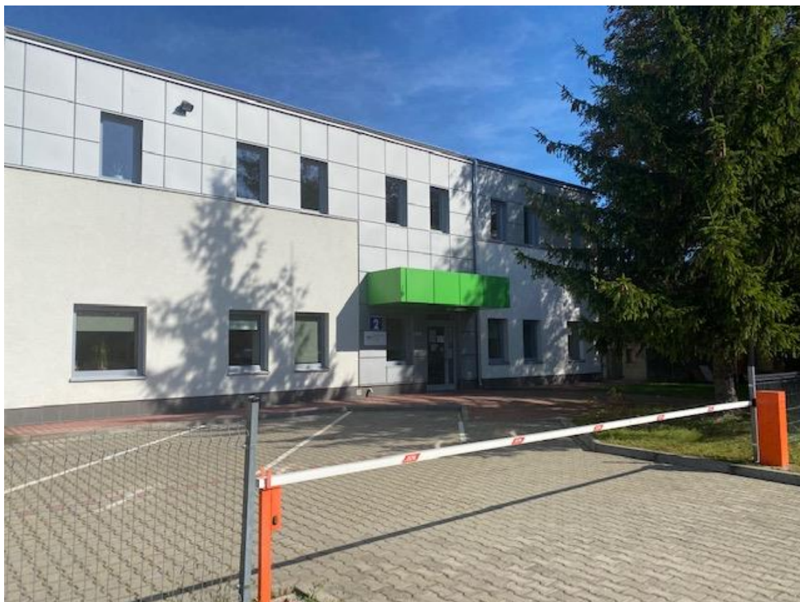
Zdjęcie 1 Wejście główne do budynku
