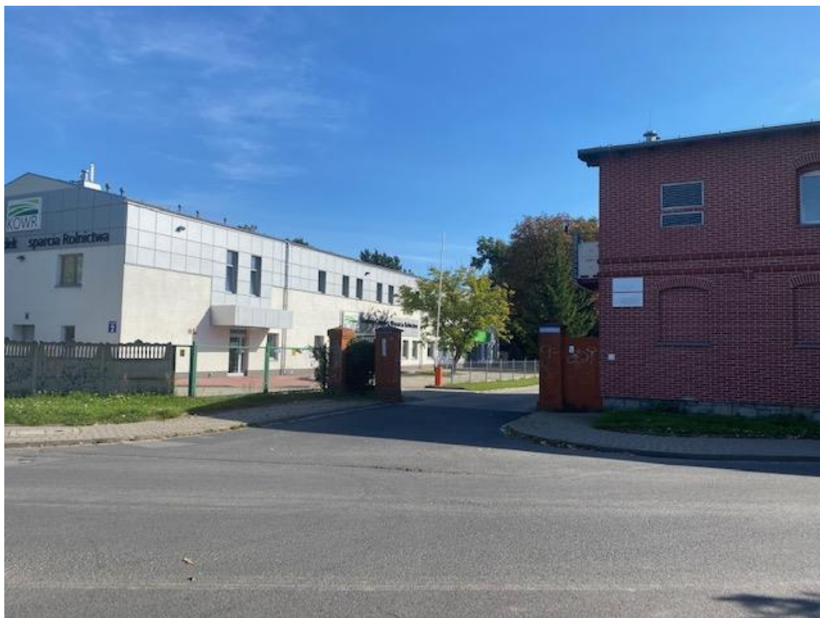
Zdjęcie 2 Wejście od ul. Kunickiego 2-4
