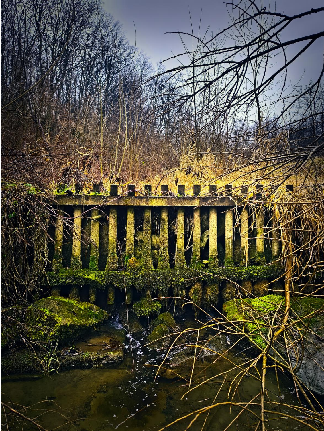
Fot. 6. Zapora przeciw-rumowiskowa o konstrukcji kratowej w km 3+808 w m. Dylągowa.
