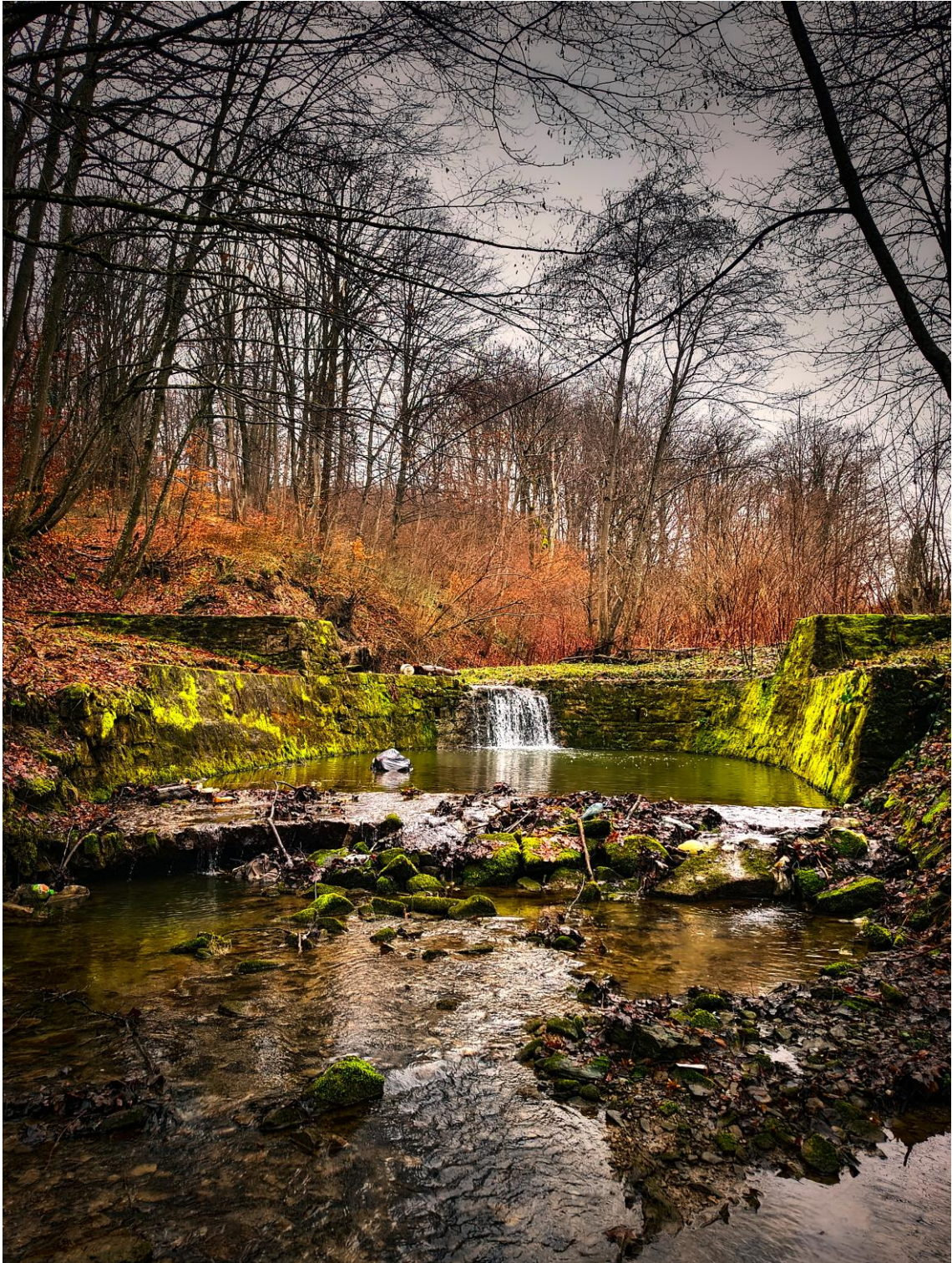
Fot. 5. „U” kształtna zaporą przeciw-rumowiskowa w km 3+004 w m. Dylągowa.
