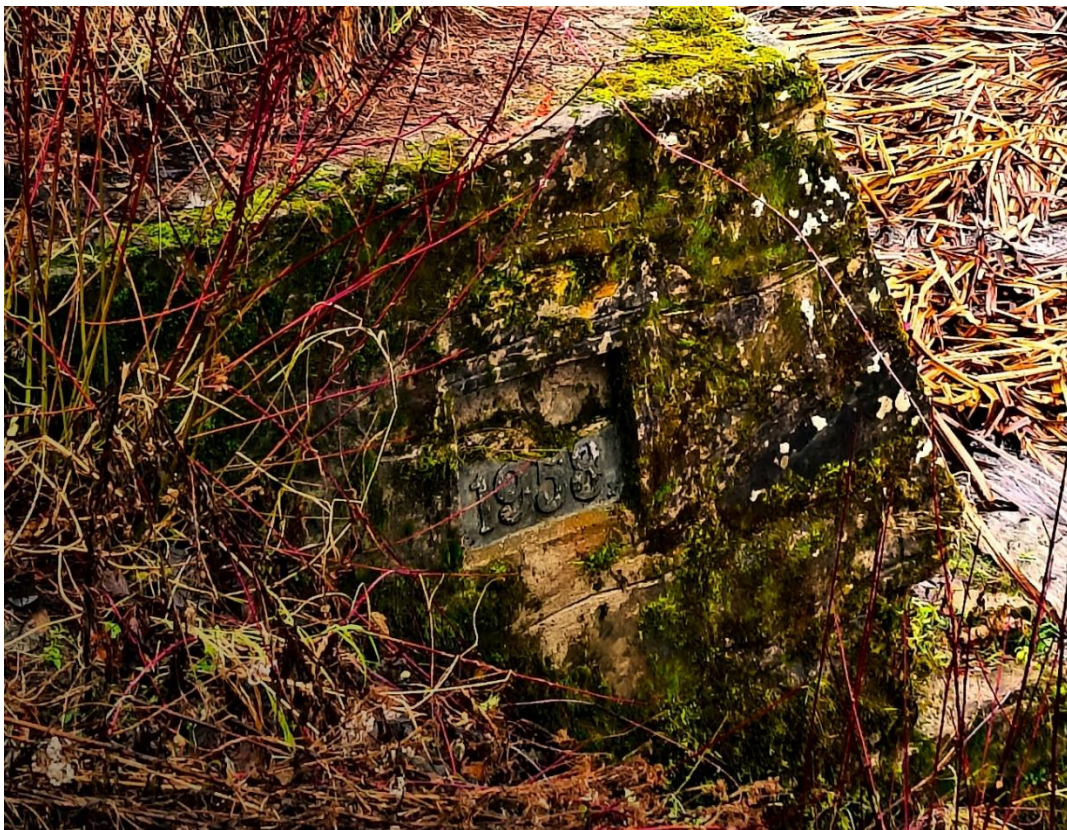
Fot. 1. Tablica pamiątkowa wmurowana w jedną z zapór przeciw-rumowiskowych odbudowaną lub wyremontowaną w 1958 roku.
