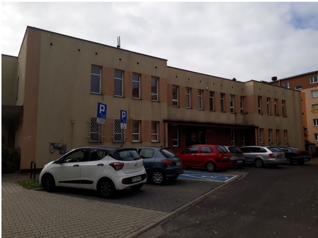
Rys. 2 Miejsce montażu SMS PEM – Przedszkole nr 20 w Piotrkowie Trybunalskim – widok z poziomu gruntu
