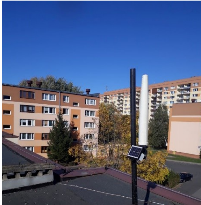
Rys. 3 Miejsce montażu SMS PEM – Przedszkole nr 20 w Piotrkowie Trybunalskim – widok na SBTk
