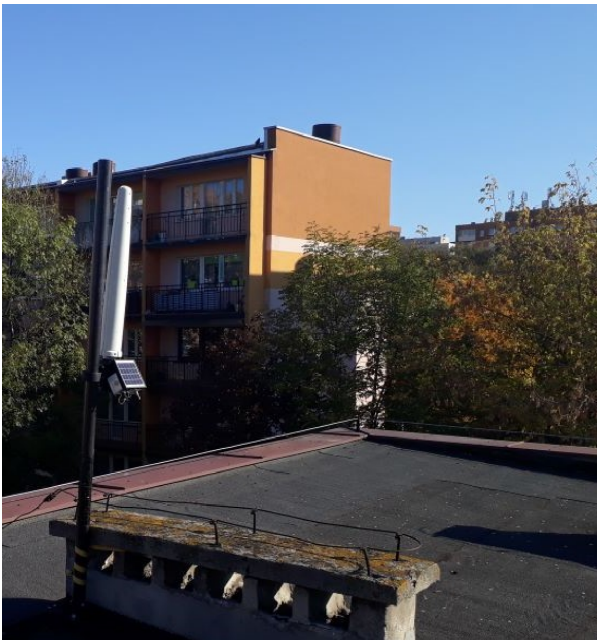
Rys. 5 Miejsce montażu SMS PEM – Przedszkole nr 20 w Piotrkowie Trybunalskim – widok na SBTk
