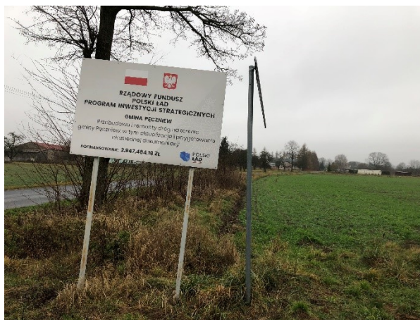
Zdjęcie nr 6 – uszkodzony znak A-7
