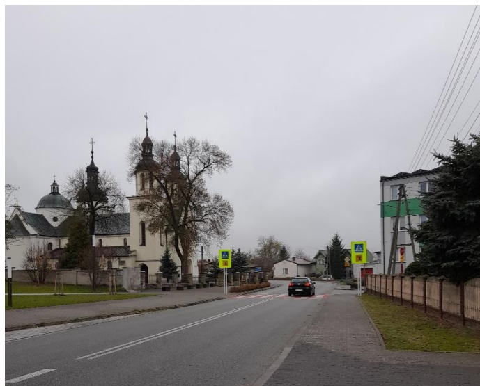
Fot. 3. Dąbrowa Zielona, RB1. Badany odcinek drogi wojewódzkiej nr 784, w kierunku Świętej Anny.
