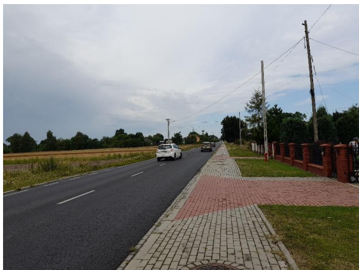
Fot. 11. Ulesie gm. Dąbrowa Zielona, RB4. Badany odcinek drogi wojewódzkiej 786 w kierunku Świętej Anny.
