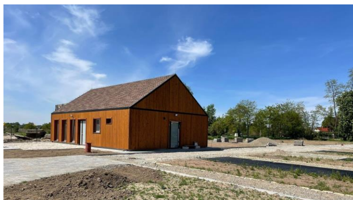
Rys 2. Budynek kamperowni w Lubaczowie
