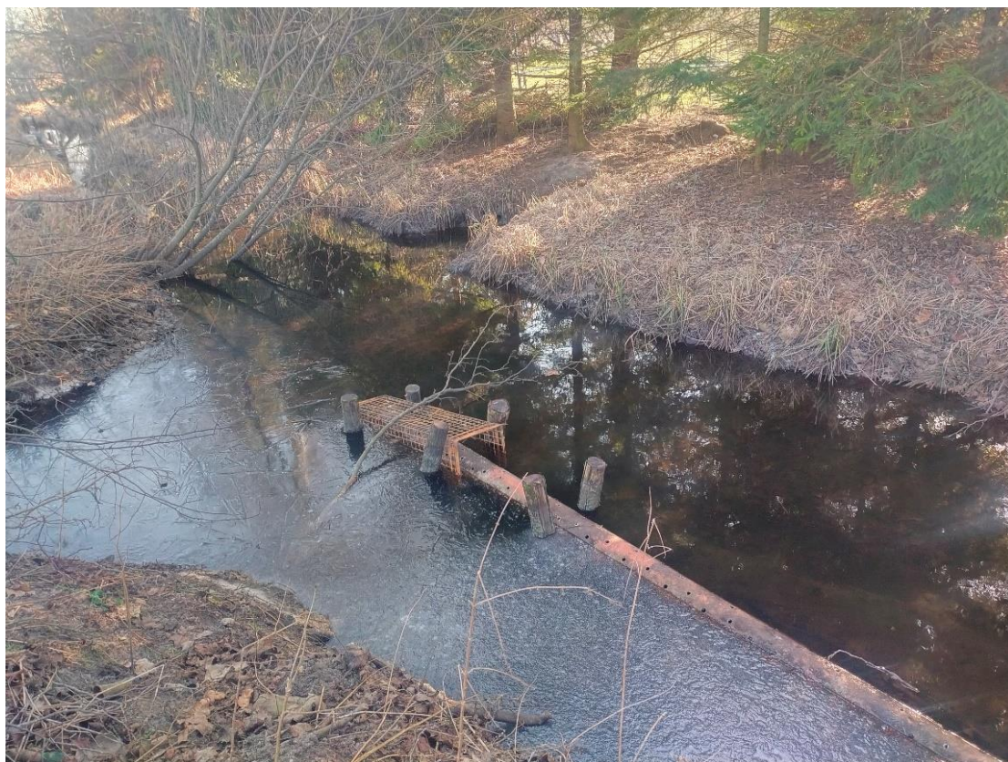
Fot. 2. Rura przelewowa nr 1
