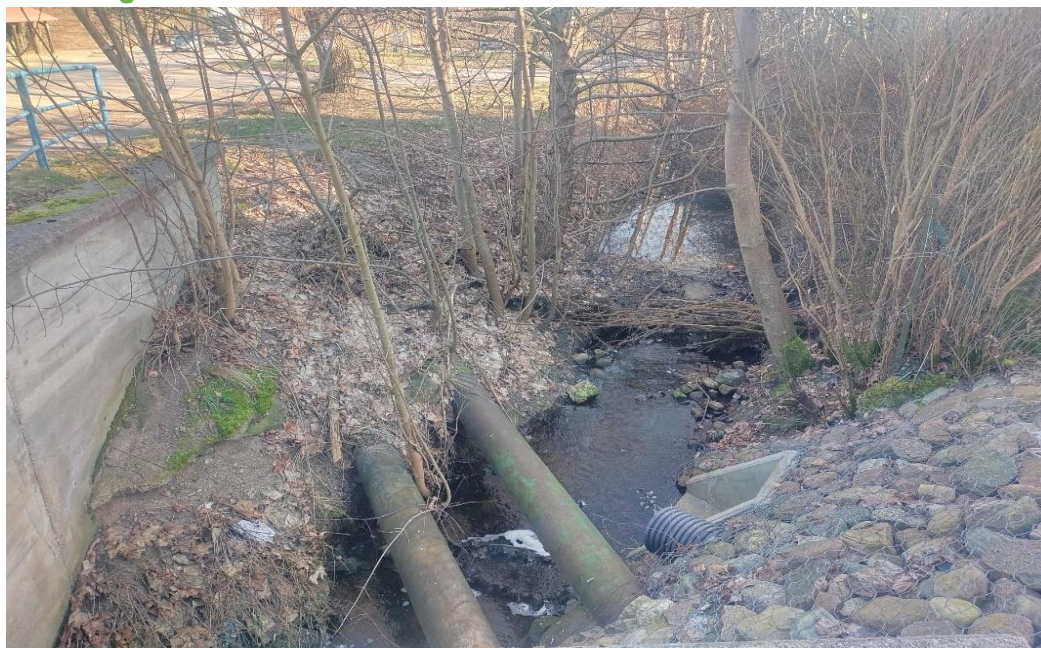
Fot. 1. Tama bobrowa do rozbiórki przy mostku drogowym (oznaczona zielonym trójkątem na mapce poglądowej (Ryc. 2)
