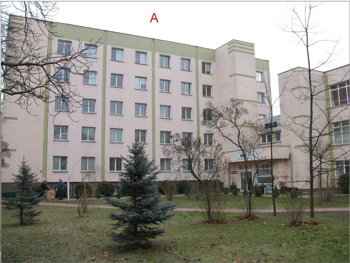
SKRZYDŁO A (HOTEL) I GŁ. WEJŚCIE DO BUD.
