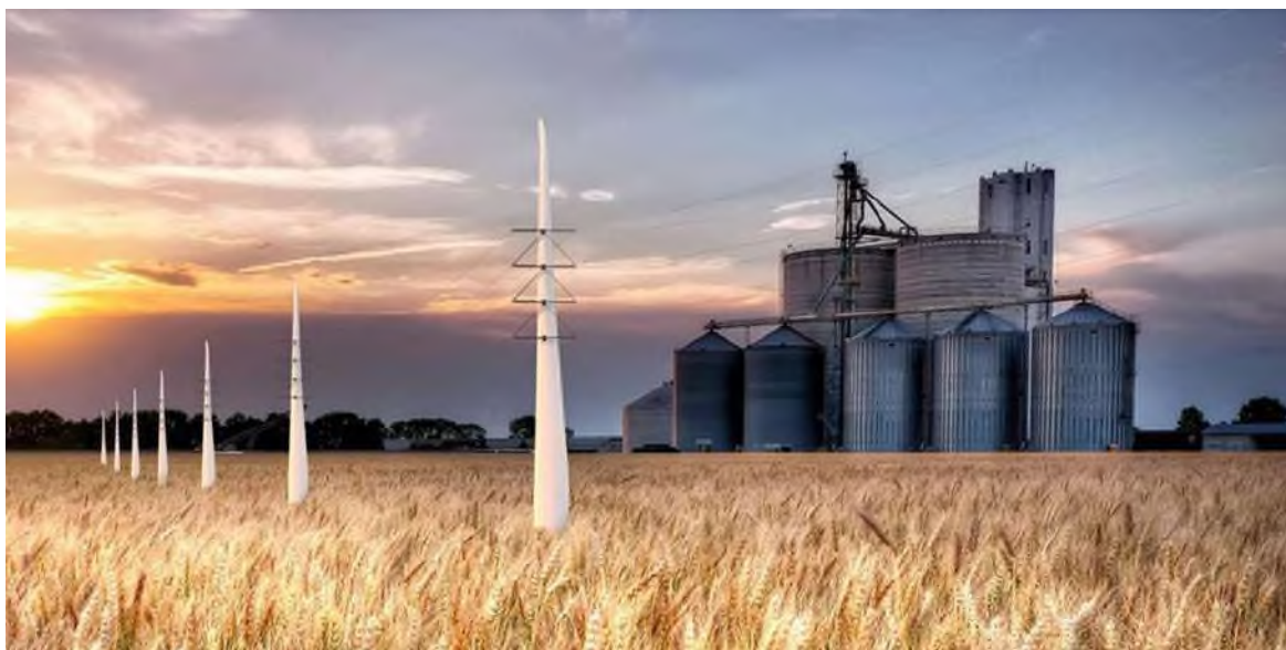
Rys. 4.7. Łopaty wiatrowe jako słupy energetyczne 481
