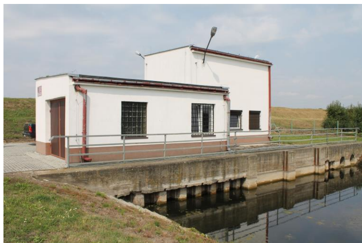
Widok na planowaną do modernizacji przepompownię
