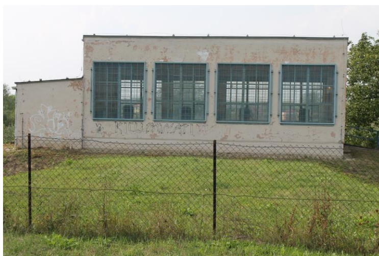
Widok na planowaną do modernizacji przepompownię Nadbrzezie
