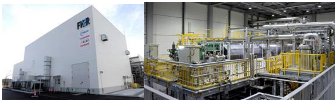
Rysunek 3 10MW elektrolizer alkaliczny zbudowany w Japonii (2020) przez Asahi Kasei na potrzeby produkcji zielonego wodoru
