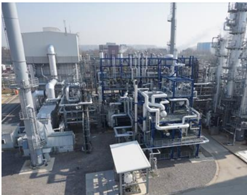
Rysunek 2 Instalacja produkcji wodoru i dwutlenku węgla na potrzeby wytwórstwa polimerów. Air Liquide, Dormagen, Niemcy. Produkcja: 22 tys. ton wodoru/r.
