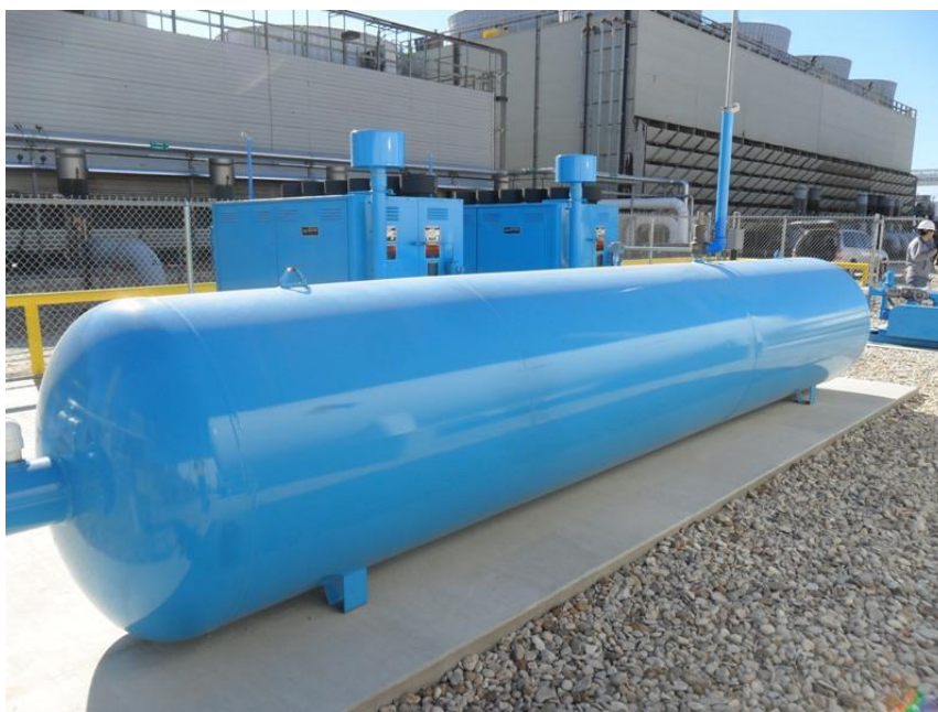
Rysunek 87 Zbiornik ciśnieniowy na wodór [456]
