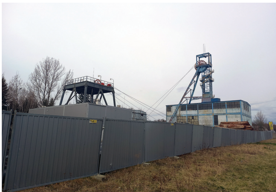
► Dla zabezpieczenia fedrujących na Górnym Śląsku kopalń rocznie wypompowuje się spod ziemi ok. 182,5 mln m 3 wody. Kluczową rolę w tym systemie odgrywa 18 pompowni Centralnego Zakładu Odwadniania Kopalń. Zasięg terytorialny CZOK-u, będącego oddziałem Spółki Restrukturyzacji Kopalń, obejmuje ponad 40 gmin na terenie Górnego Śląska i zachodniej Małopolski. Fot. Michał Wroński
