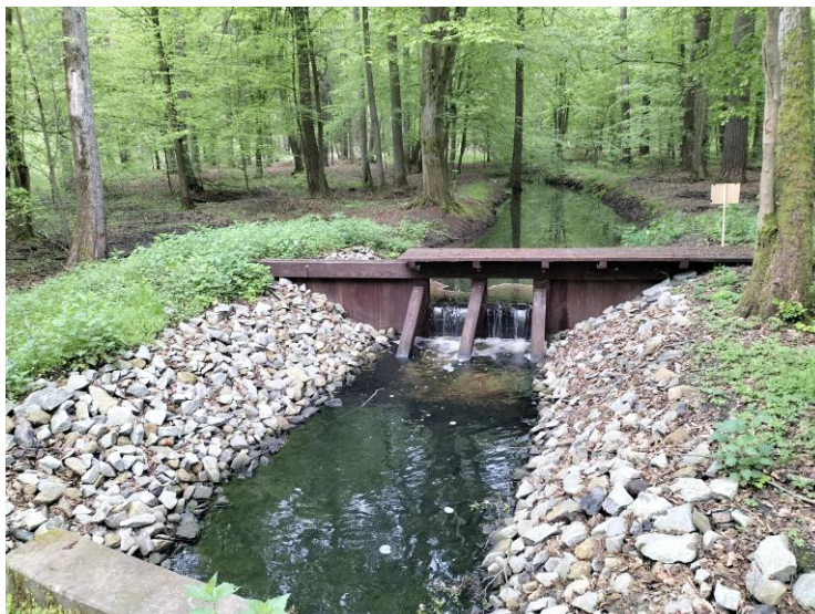
Fot. 6. Element małej retencji w nadleśnictwie (fot. Nadleśnictwo Żmigród)
