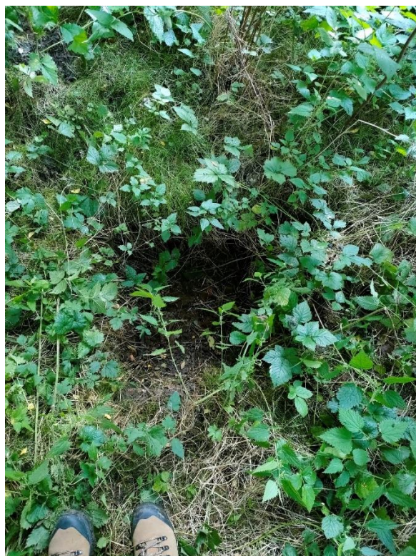
Fot. 14. Wlot do podziemnego obiektu P11 wraz z otoczeniem
