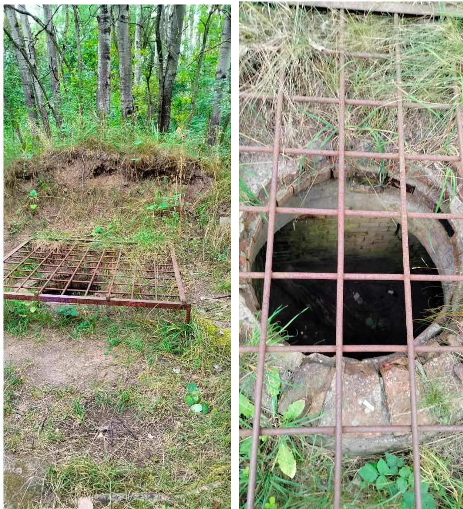
Fot. 10. Wlot do podziemnego obiektu P8 wraz z otoczeniem
