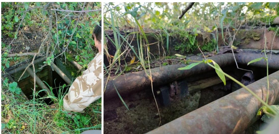
Fot. 12. Wlot do podziemnego obiektu P10 wraz z otoczeniem
