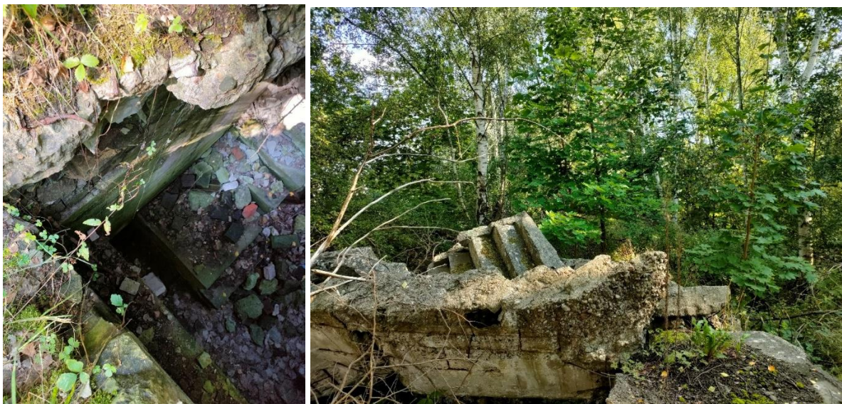
Fot. 8. Wlot do podziemnego obiektu P7 wraz z otoczeniem
