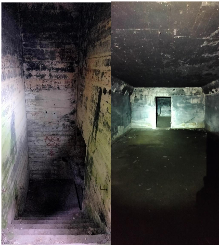
Fot. 2. Zejście do obiektu P1 i pomieszczenia wewnątrz obiektu.
