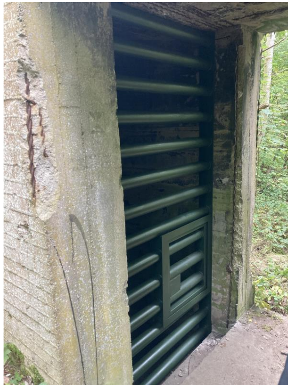
Fot. 1b. Fot. Wejście do obiektu P1 z zakratowaniem
