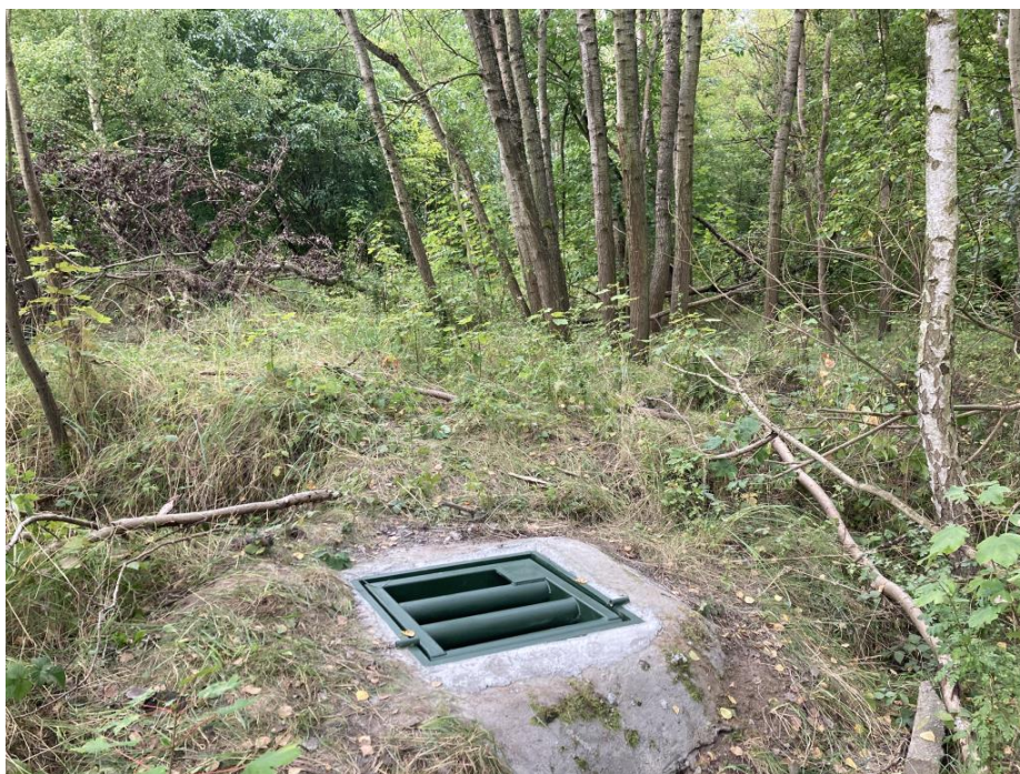
Fot. 3b. Wlot do podziemnego obiektu P2 po zakratowaniu.
