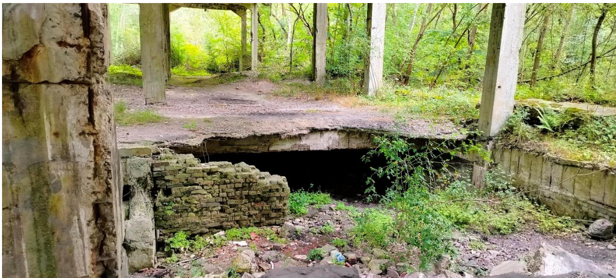
Fot. 6. Wlot do podziemnego obiektu P5
