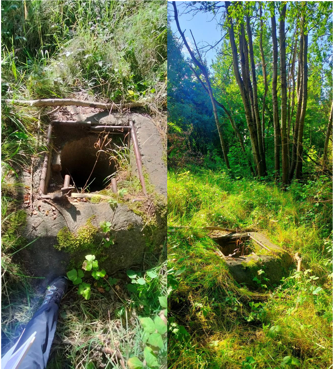
Fot. 3a. Wlot do podziemnego obiektu P2 wraz z otoczeniem przed zakratowaniem.
