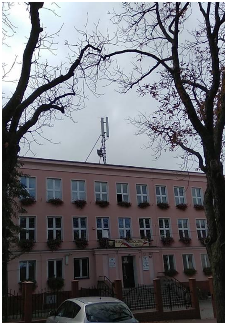
Fot. 1: Widok anten stacji bazowej: ID ZGO1021, zlokalizowanej przy ul. Strzeleckiej 7 w Zielonej Górze
