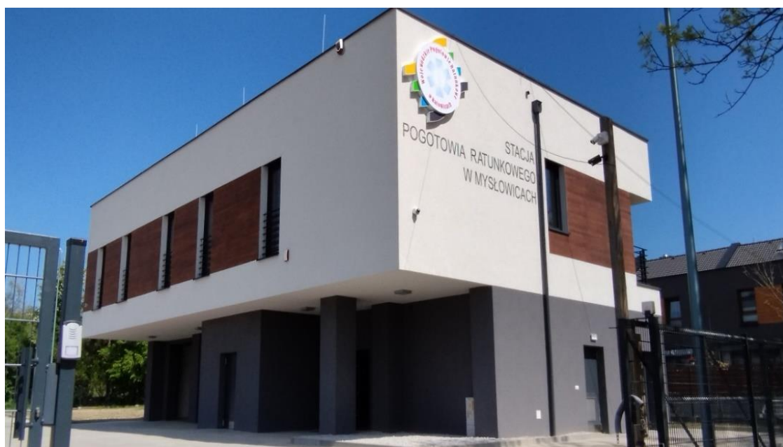
Stacja pogotowia ratunkowego przy ul. Mikołowskiej 50L (źródło: zdjęcie własne)
