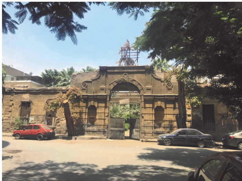
Brama wjazdowa do pałacu Tussuna, a za nią rumowisko.
