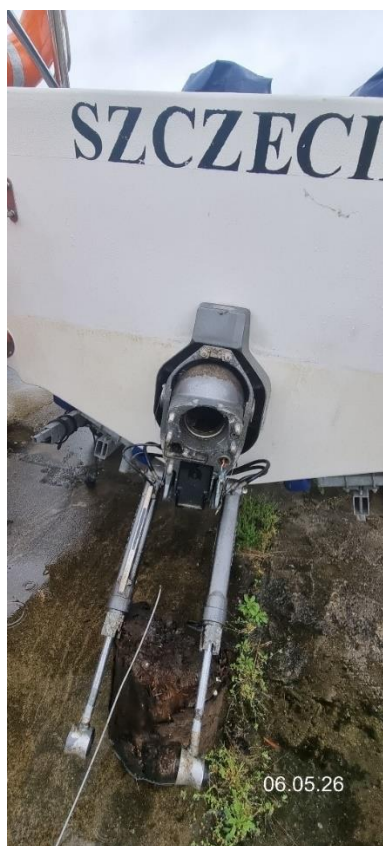
Foto nr 15 ŁM OIRM – 1 Miejsce łączenia przekładni z silnikiem w dniu 06.05.2026
