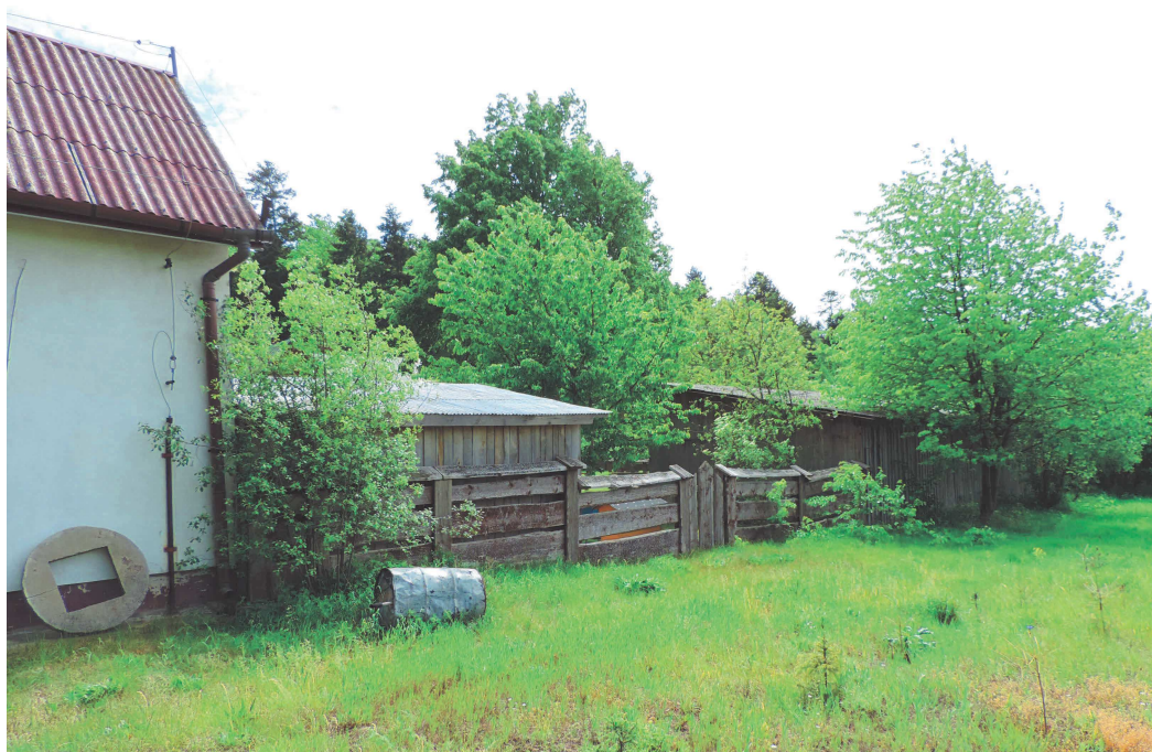
OGRODZENIE TYLNE DZIAŁKI OZN. NR 5 NA PLANIE SYTUACYJNYM - RYS. NR 1 (FOTO Nr 9)
