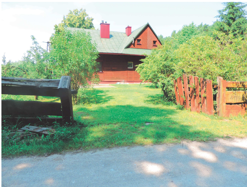
BRAMA OZN. NR 1a NA PLANIE SYTUACYJNYM - RYS. NR 1 OGRODZENIA FRONTOWEGO (FOTO Nr 2)
