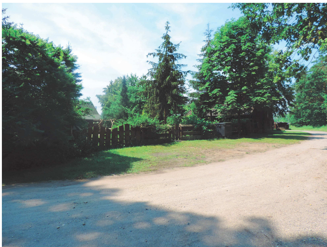
BRAMA I FURTA OZN. NR 2a NA PLANIE SYTUACYJNYM - RYS. NR 1 OGRODZENIA BOCZNEGO (FOTO Nr 6)
