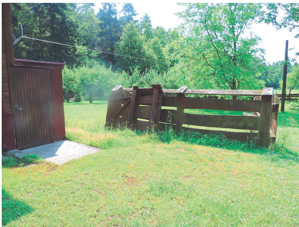
OGRODZENIE WEWNĘTRZNE DZIAŁKI OZN. NR 8 NA PLANIE SYTUACYJNYM - RYS. NR 1 (FOTO Nr 16)
