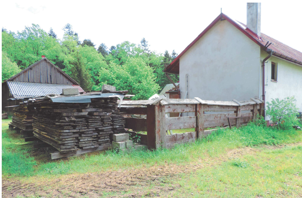
OGRODZENIE TYLNE DZIAŁKI OZN. NR 4 NA PLANIE SYTUACYJNYM - RYS. NR 1 (FOTO Nr 8)
