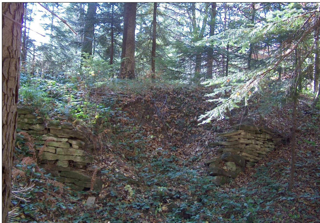
Ryc. 38. Pozostałości murku oporowego na trasie zlikwidowanego torowiska kolejki leśnej.
