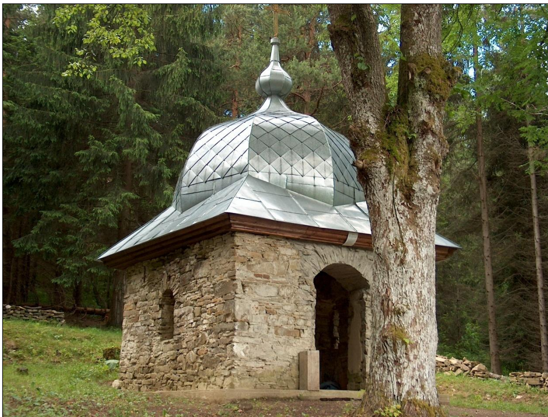
Ryc. 32. Murowana kaplica greckokatolicka wybudowana przed rokiem 1879, oddz. 115b, I-ctwo Czarny Las.
