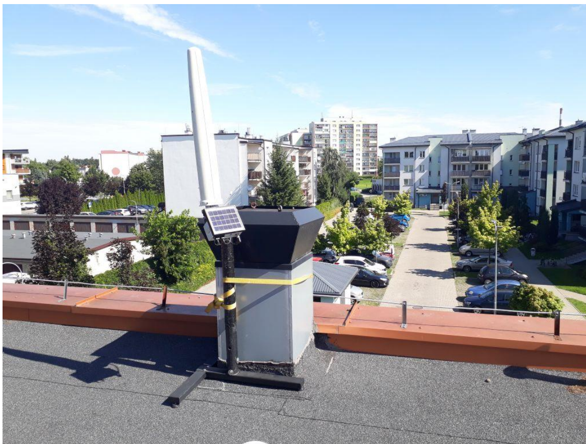
Rys. 2. Miejsce montażu SMS PEM – Przedszkole Samorządowe nr 26
