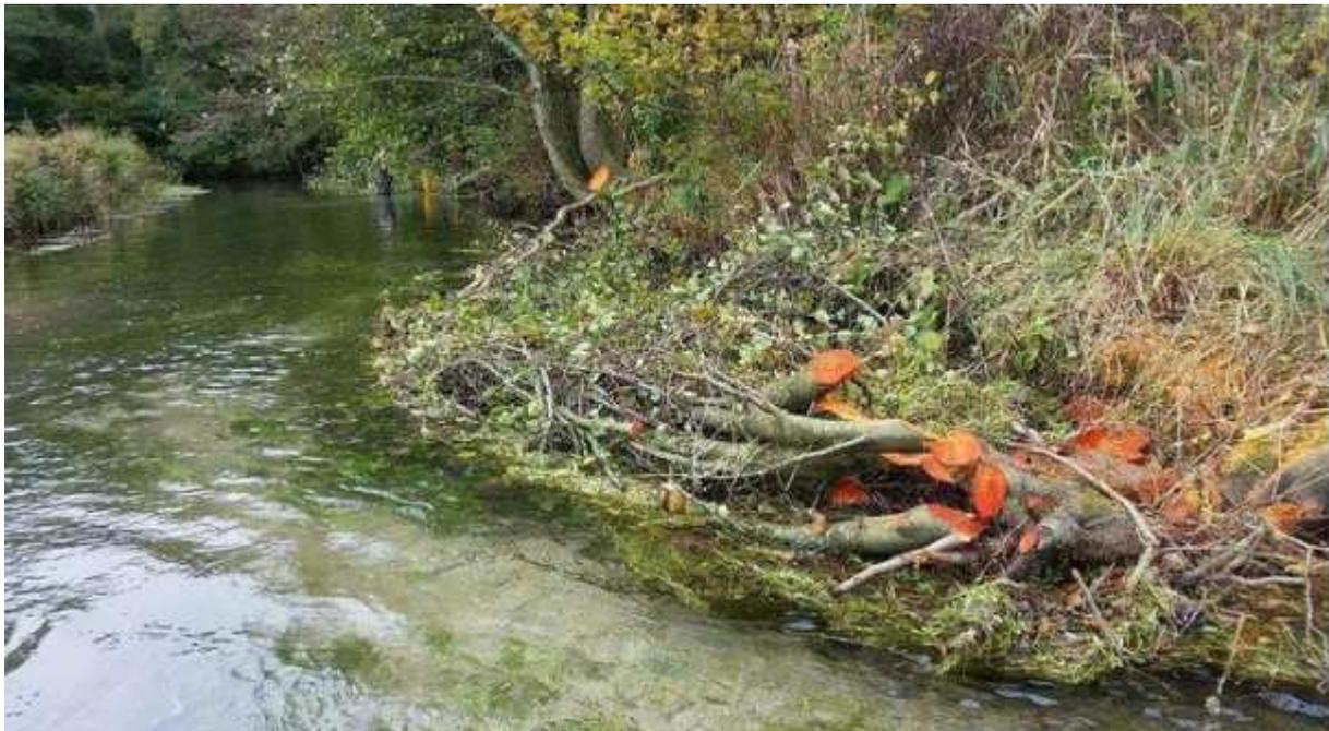
Fotografia 30. Naturalne deflektory wykonane z gałęzi olszyny i wikliny. Oprócz funkcji hydromorfologicznych zapewniają również funkcje siedliskowe. Struktury wprowadzone w ramach projektu renaturyzacji rzeki Dever.
