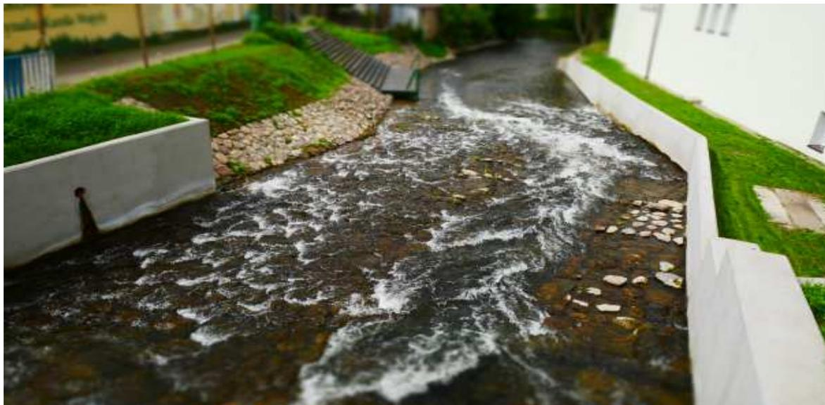
Fotografia 41. Miejsce po zlikwidowanych ruinach piętrzenia na Drawie w Złocieńcu. Rampa kamienna wykonana w technologii „grouted rock” – mozaiki kamieni ułożonej na betonie
