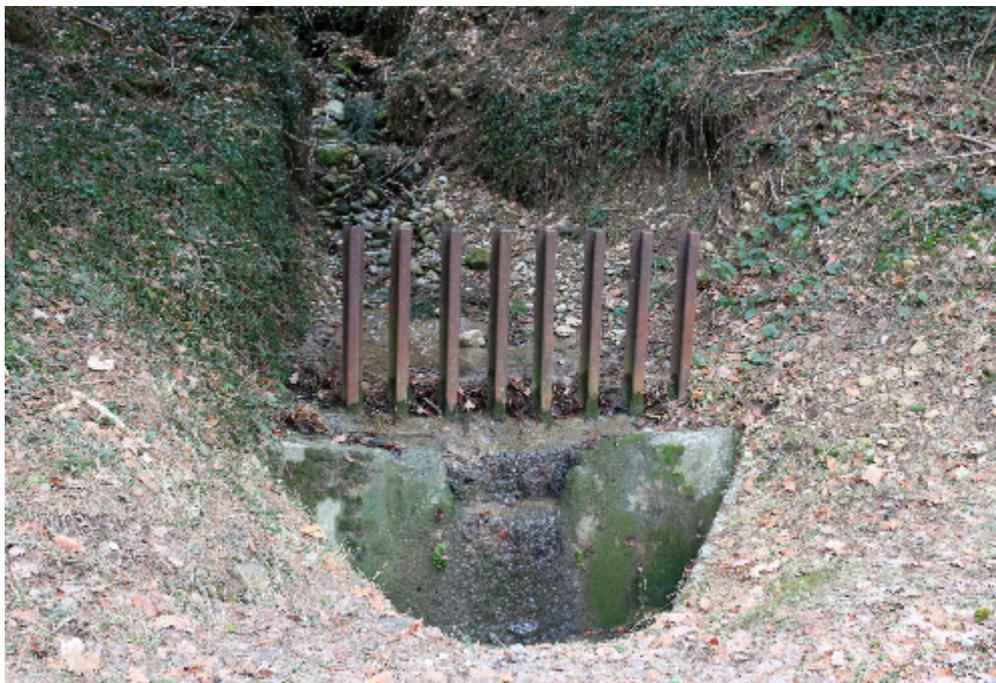
Fotografia 21. Przed ryzykiem zatykania przepustów przez znoszone przez wodę martwe fragmenty drzew można się zabezpieczyć – łapacz rumoszu drzewnego w Lesie Bregenckim w Austrii. Podobne rozwiązania są możliwe także na dużej skale, jako prewencja zatorów na mostach i in. antropogenicznych zwężeniach koryta.
