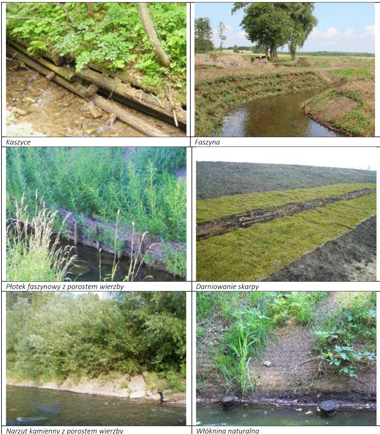
Fotografia 36. Przykłady przyjaznych naturze umocnień biologicznych i biotechnicznych.
