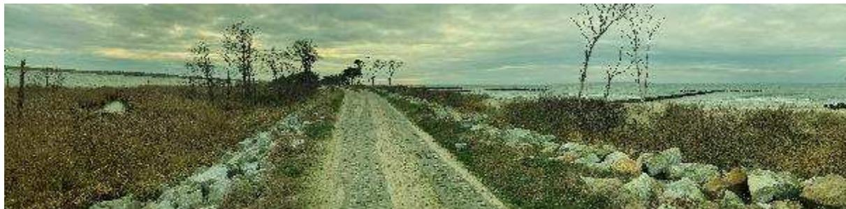
Fotografia 80. Fragmentu wału przeciwsztormowego, do rozważenia likwidacji i umożliwienia przelewania się fal sztormowych przez mierzeję, w najwęższym miejscu mierzei jeziora Kopań.
