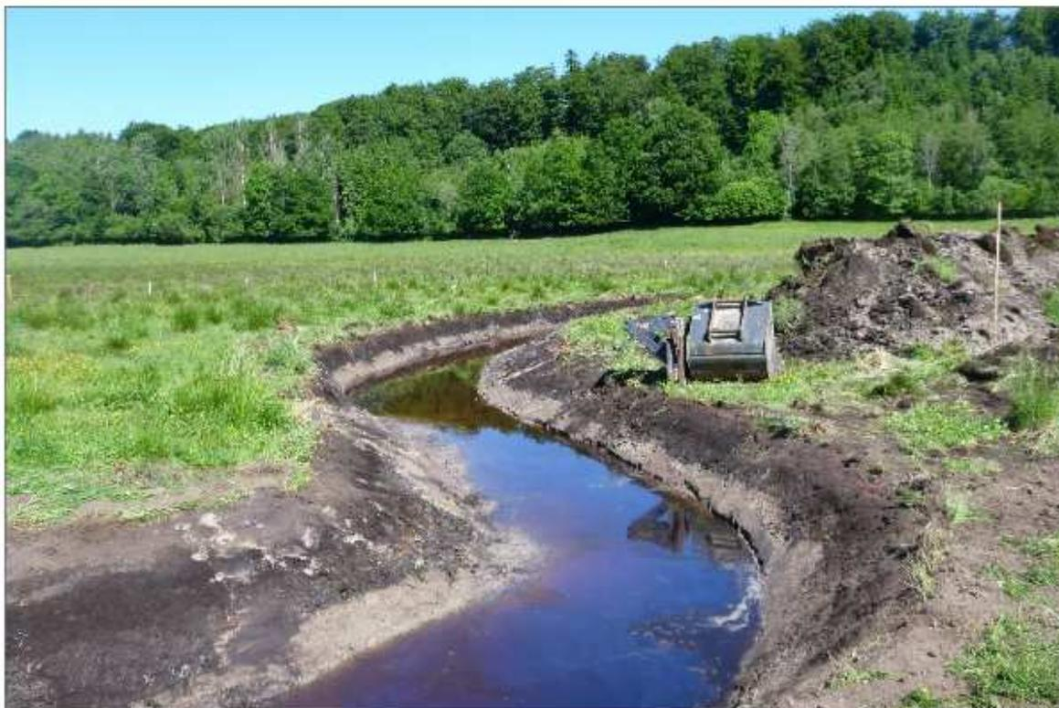
Fotografia 31. Utworzenie nowego meandrującego koryta rzeki Fyleån (Szwecja)
