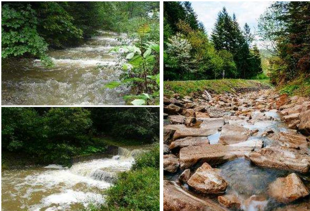
Fotografia 40. Renaturalizacja potoku poprzez przebudowę stopni betonowych zniszczonych podczas powodzi.
