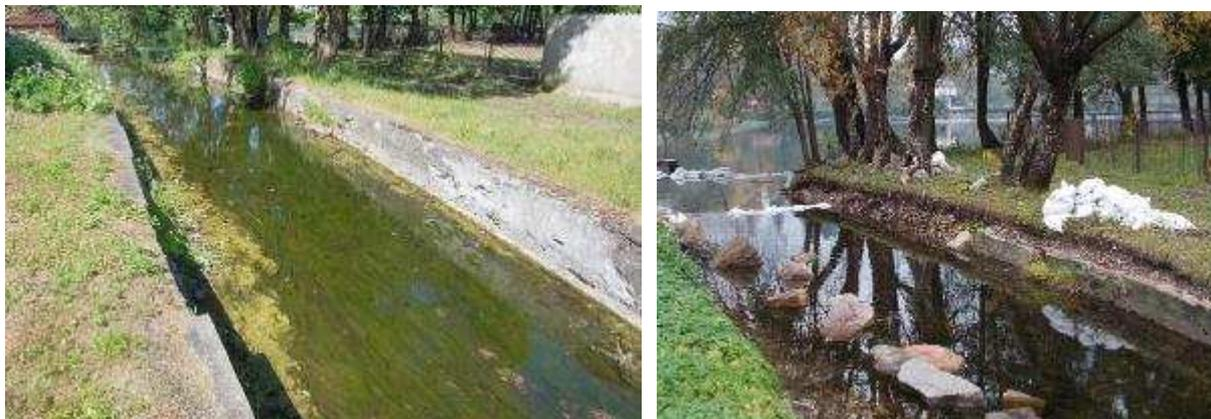
Fotografia 58. Strefa ujściowa rzeki Białej z jeziora Ławiczka przed (po lewej) i w trakcie (po prawej) renaturyzacji polegającej na usunięciu umocnień wykonanych z betonu.
