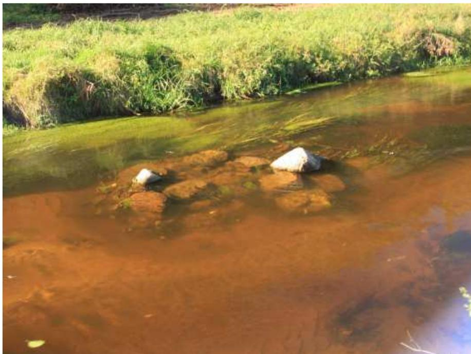
Fotografia 28. Kamienne wyspy na podkładzie faszynowym wprowadzone w rzece Kwacza, Park Krajobrazowy Doliny Słupi.
