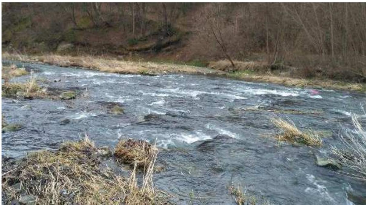
Fotografia 23. Podniesienie i odtworzenie korony bystrza przez wprowadzenie kamieni – wywołało samorzutne zasypanie przez rzekę wyrwy w dnie, podmywającej stopień położony powyżej. Projekt „Tarliska Górnej Raby”.
