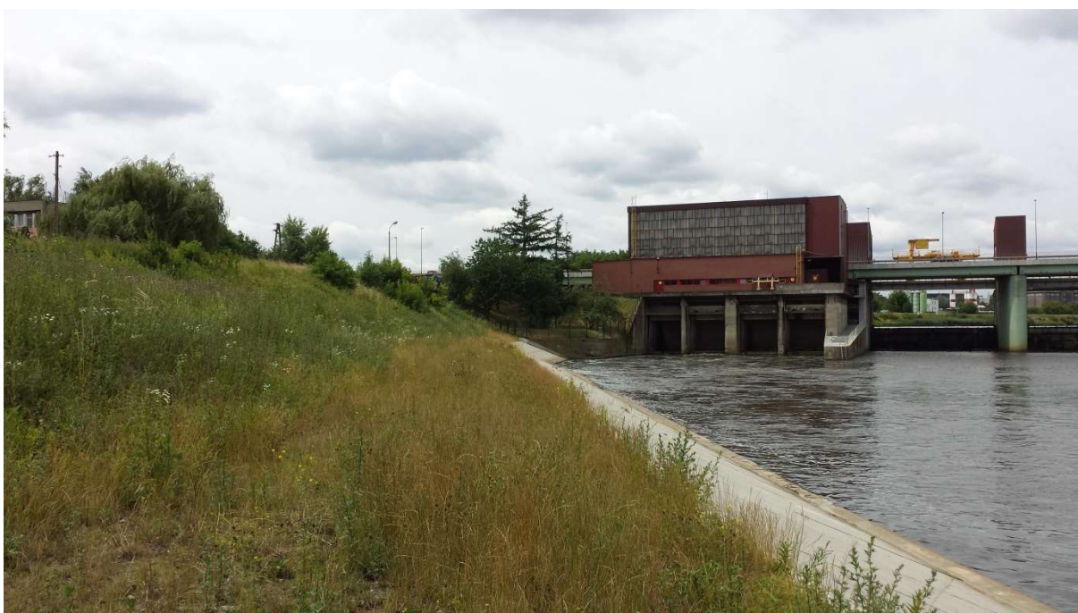
Zdj. 4 - Widok z międzywala na skarpe dowodną rozbudowywanego wału przeciwpowodziowego i stopień Dąbie. Widoczne umocnienie płytami betonowymi podstawy skarpy wału oraz wylot z elektrowni wodnej stopnia Dąbie
