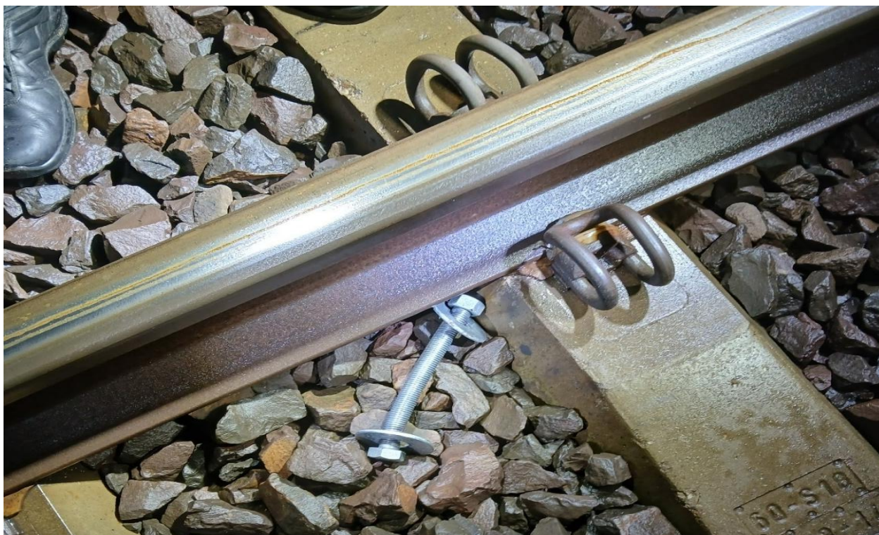
Zdjęcie 9. Porzucony element – śruba (źródło: komisja kolejowa)
