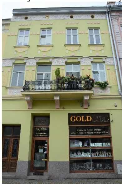
Przemyśl, kamienica ul. Kazimierza Wielkiego 20 po remoncie
