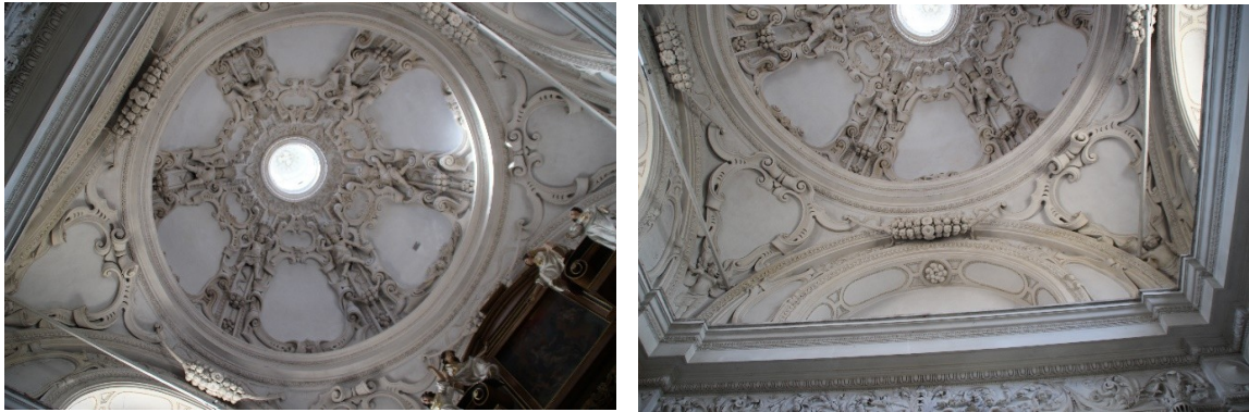
Krosno, latarnia kaplicy Oświęcimów, po lewej przed rozpoczęciem prac, po prawej po zakończeniu
