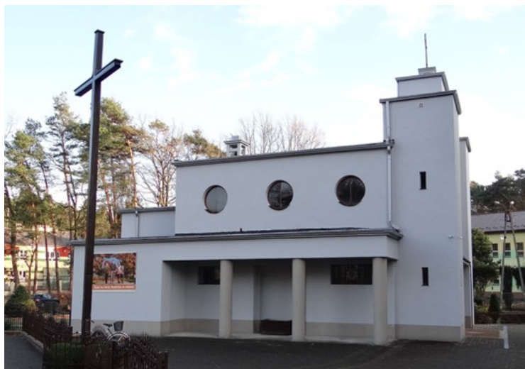
Pustków osiedle, kościół po zakończeniu remontu
