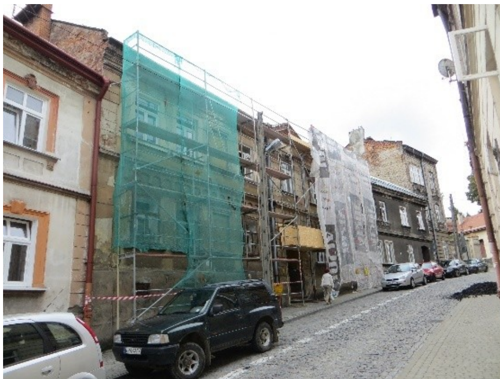
Kamienica ul. Władycze 13 w trakcie remontu
