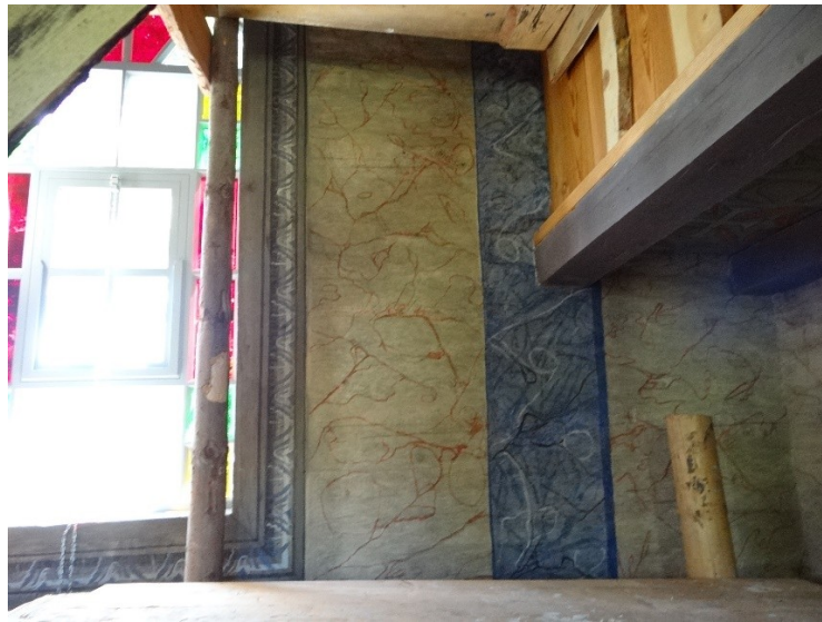
Blizianka, polichromia ścienna w trakcie prac
