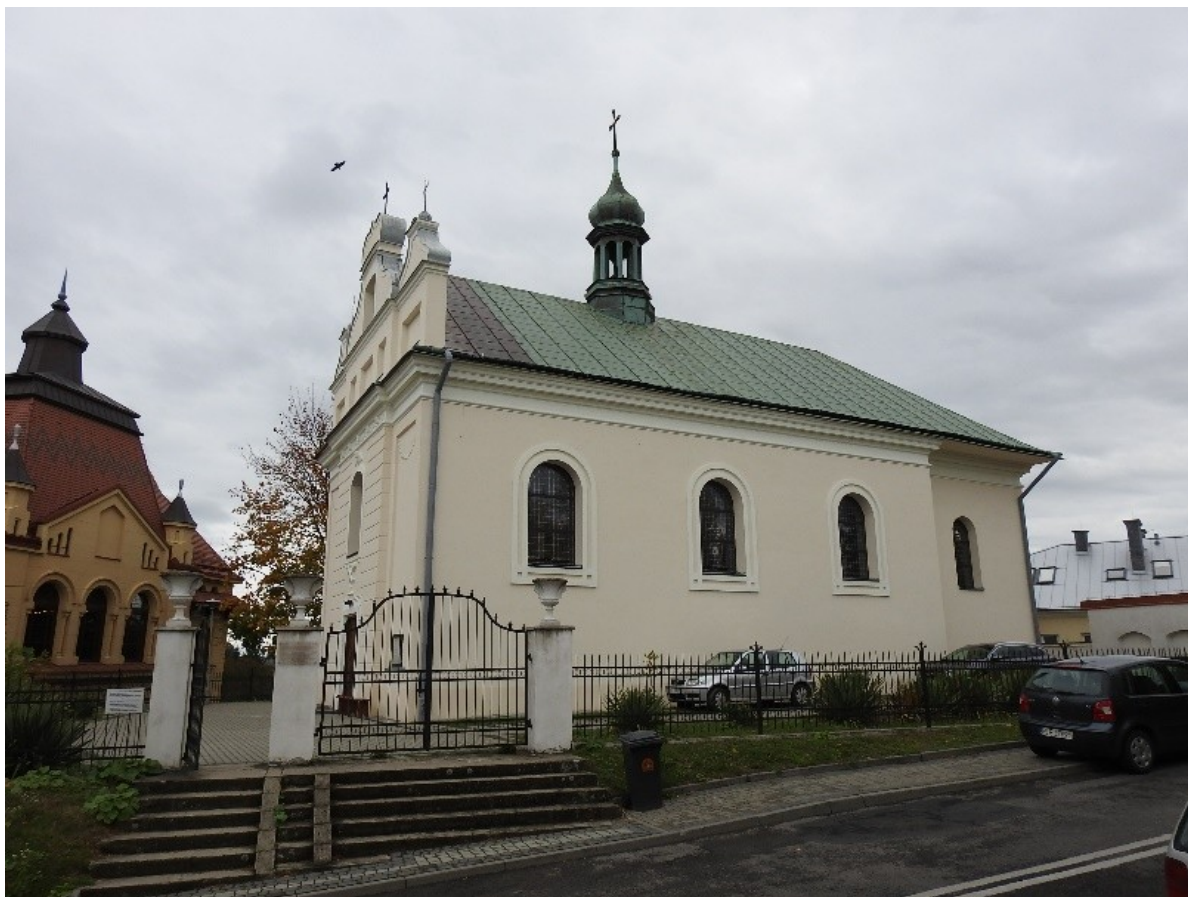
Leżajsk, kościół p.w. Jezusa Miłosiernego po zakończeniu prac
