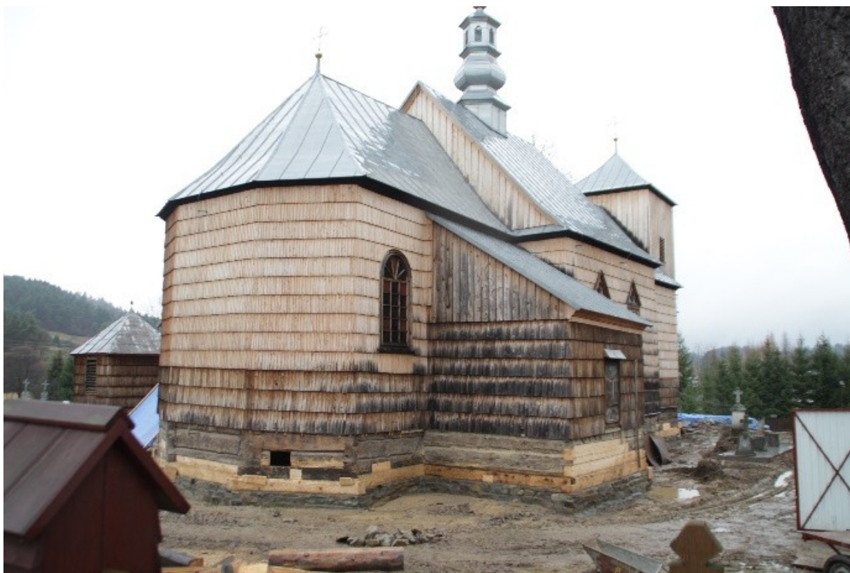
Stefkowa, dawna cerkiew w trakcie prac
