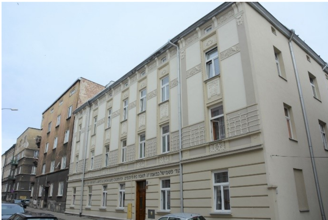
Przemyśl, kamienica ul. Moniuszki 7 po remoncie
