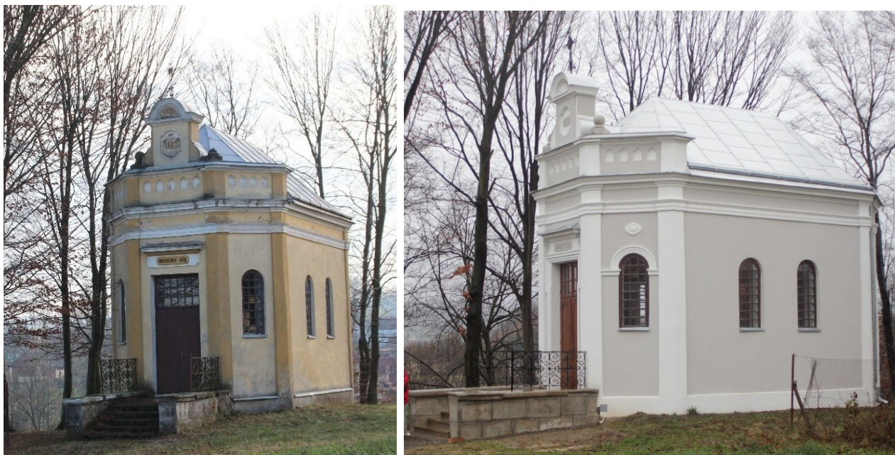
Nozdrzec, kaplica pałacowa, po lewej przed rozpoczęciem prac, po prawej po zakończeniu prac
