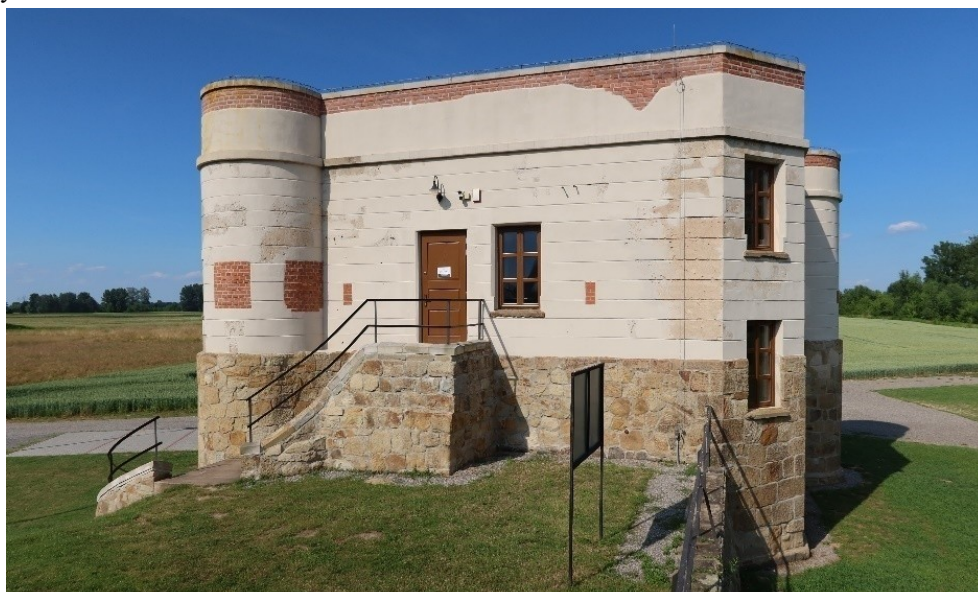
Chodaczów, strażnica po zakończeniu remontu
