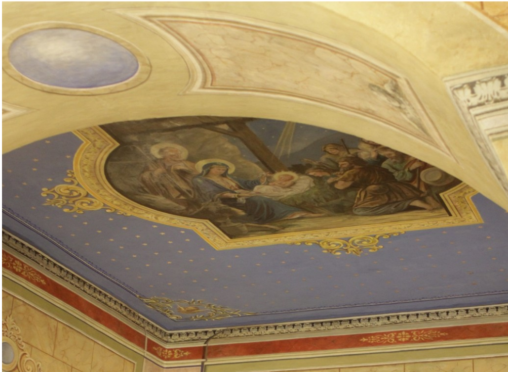
Trzciana, dekoracja malarska wnętrza, po zakończeniu prac konserwatorskich
