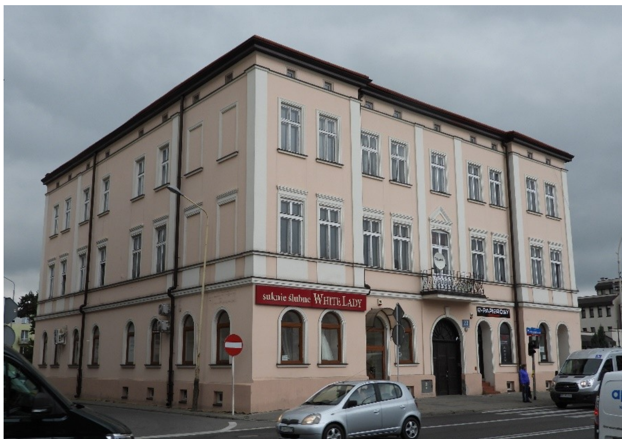
Rzeszów, kamienica al. Piłsudskiego 22
