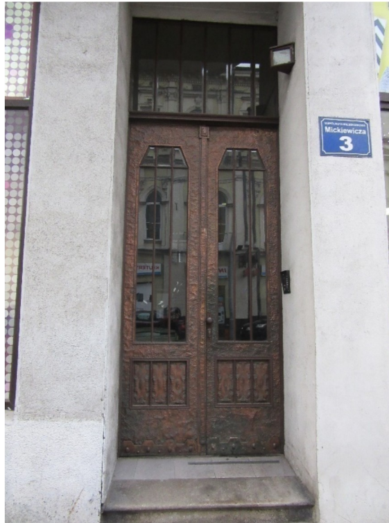
Ul. Mickiewicza 3, drzwi wejściowe po zakończeniu prac konserwatorskich
