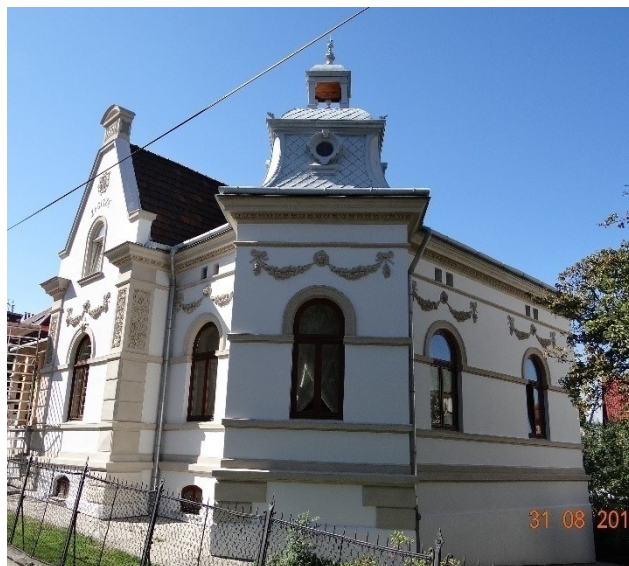
Łańcut, willa Zacisze po zakończeniu prac konserwatorskich
