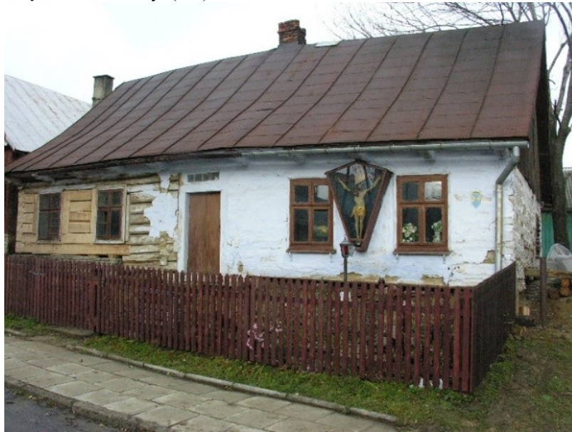
Dębowiec, dawny szpital ubogich, stan przed rozpoczęciem prac
