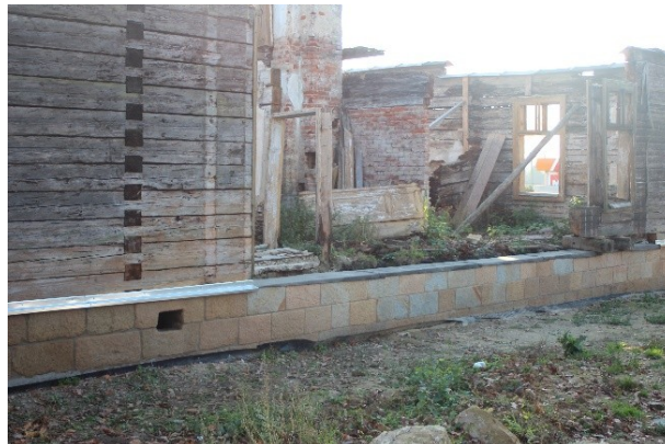
Korczyna, willa „Doktorówka” przed rozpoczęciem prac po lewej, po prawej po zakończeniu pierwszego etapu
