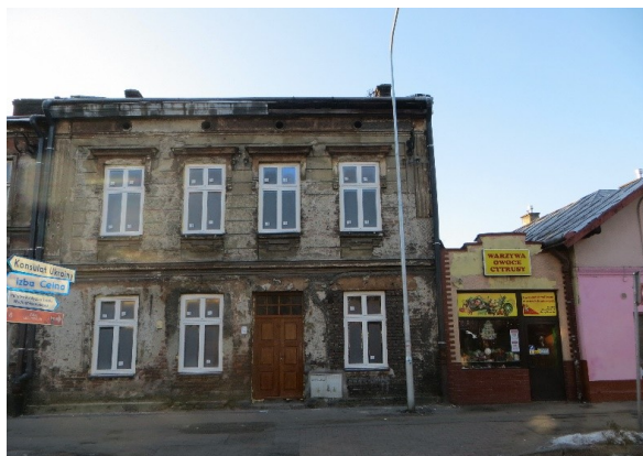
Kamienica, ul. Dworskiego 76 po wymianie stolarki okiennej i drzwiowej
