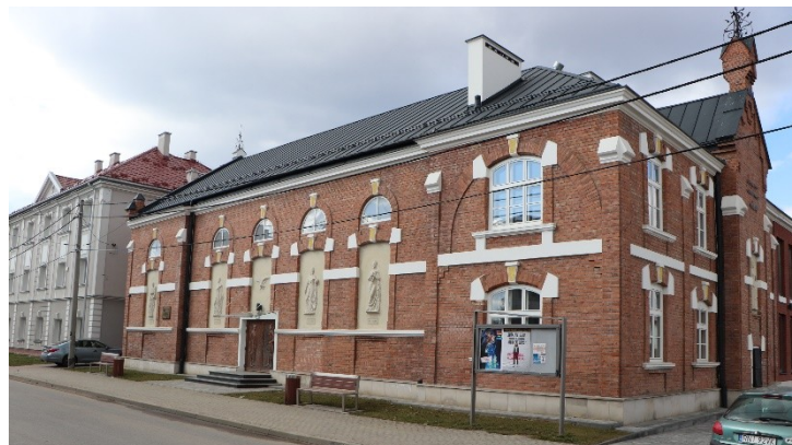
Nisko, budynek Towarzystwa Gimnastycznego „Sokół”
