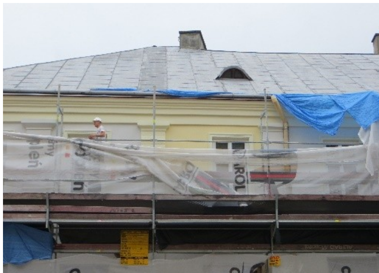
Kamienica, ul. Słowackiego 1 w trakcie prac konserwatorskich
