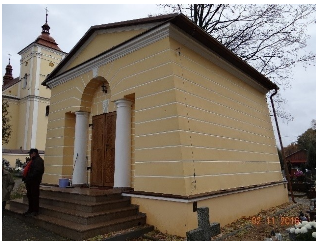
Majdan Królewski, kaplica Kozłowieckich na cmentarzu parafialnym po zakończeniu prac konserwatorskich
