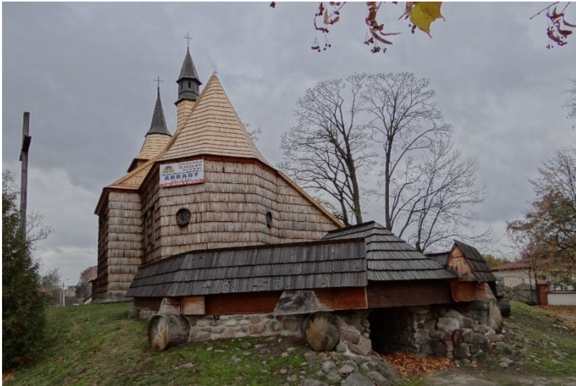
Cmolas, kościół po zakończeniu prac
