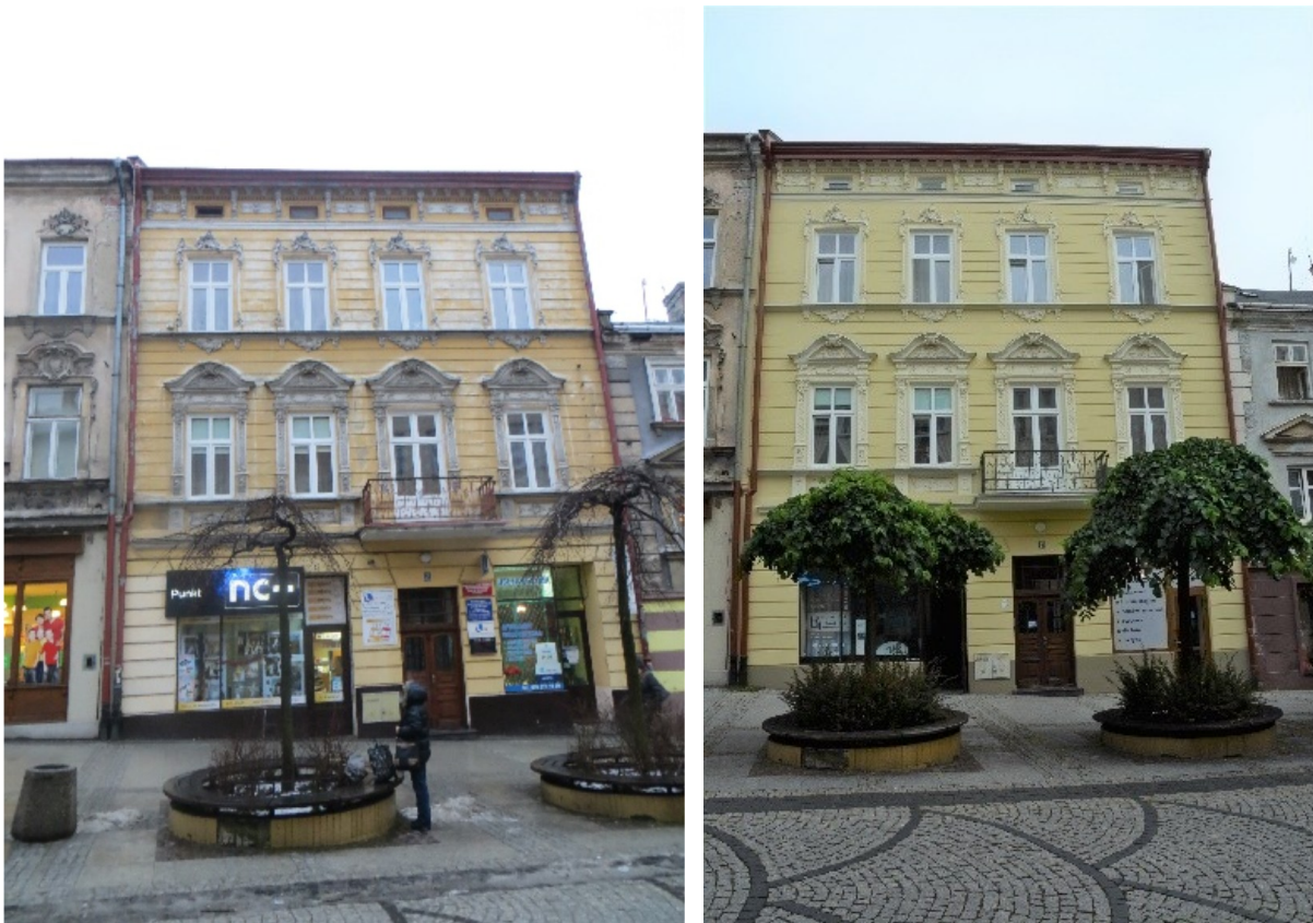
Przemyśl, kamienica ul. Franciszkańska 7, po lewej przed, po prawej po zakończeniu prac konserwatorskich
