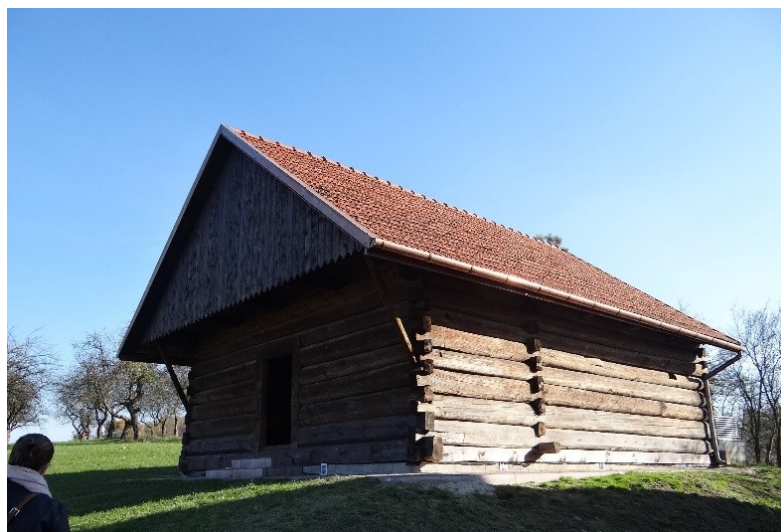
Grodzisko Dolne, spichlerz plebański po zakończeniu prac konserwatorskich
