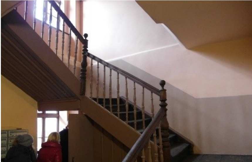
Kamienica, Plac Rybi 1, stolarka schodów po pracach konserwatorskich
