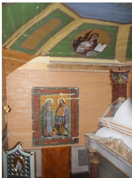
Rzepedź, dekoracja malarska w trakcie prac konserwatorskich
