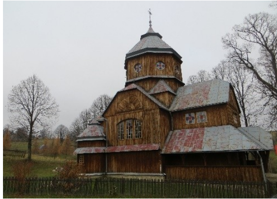
Roztoka, dach przed rozpoczęciem prac
