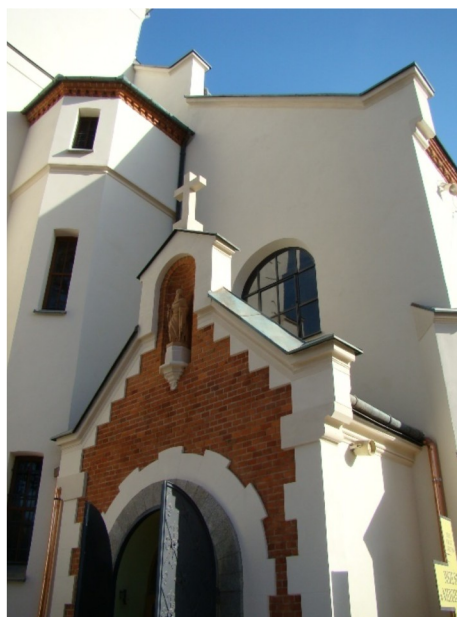
Łańcut, kościół farny, po zakończeniu prac przy elewacji
