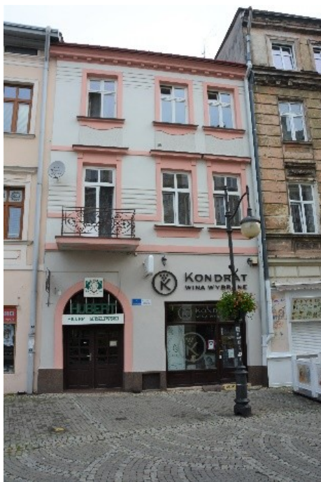
Przemyśl, ul. Kazimierza Wielkiego 1, kamienica po remoncie elewacji
