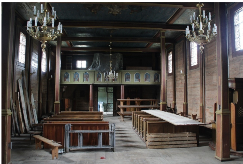
Domaradz, wnętrze kościoła w trakcie prac
