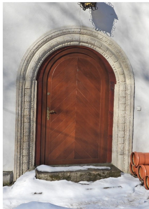
Lesko, portal renesansowy po zakończeniu prac
