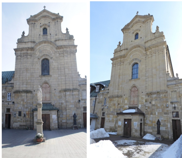
Krosno, zespół klasztorny oo. Kapucynów, fasada kościoła po lewej przed rozpoczęciem prac, po prawej po zakończeniu
