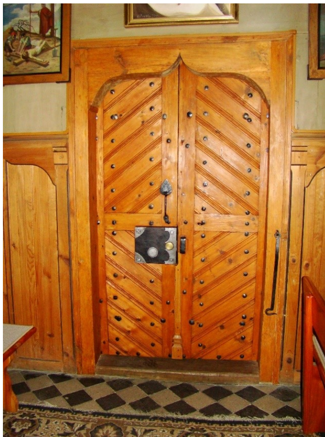
Lubla, drzwi między zakrystią a prezbiterium po zakończeniu prac
