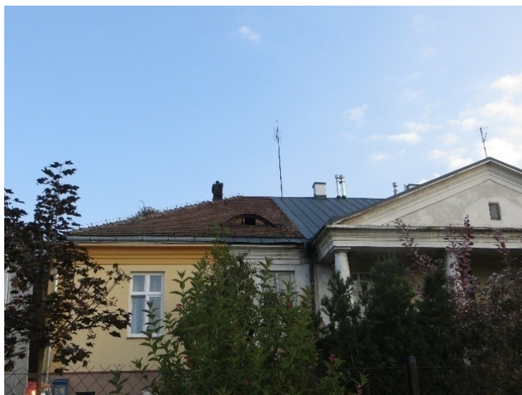
Nehrybka, dwór w trakcie prac konserwatorskich
