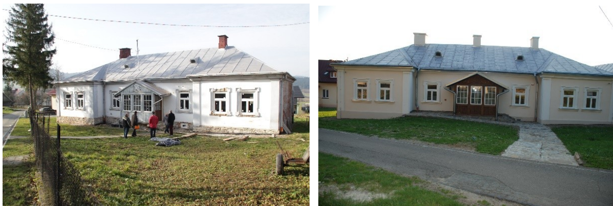
Jaślicka, po lewej budynek plebanii przed rozpoczęciem prac, po prawej po zakończeniu prac
