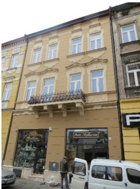
Ul. Kazimierza Wielkiego 12, elewacja po remoncie
