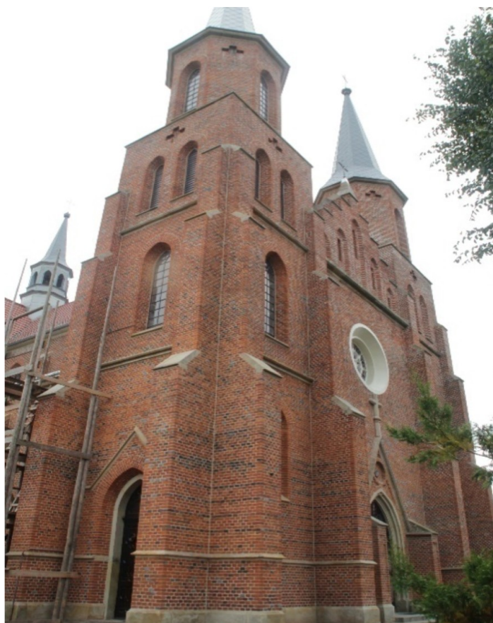
Odrzykoń, kościół po zakończeniu prac
