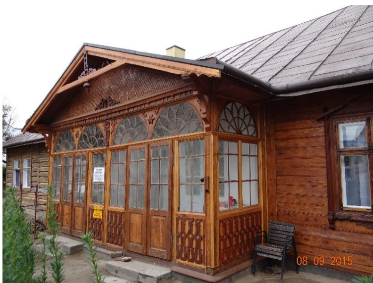
Łańcut, „dworek modrzewiowy pod bocianami” po zakończeniu prac
