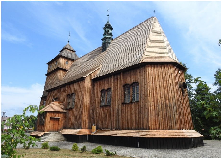
Poręby Dymarskie, kościół po zakończeniu prac
