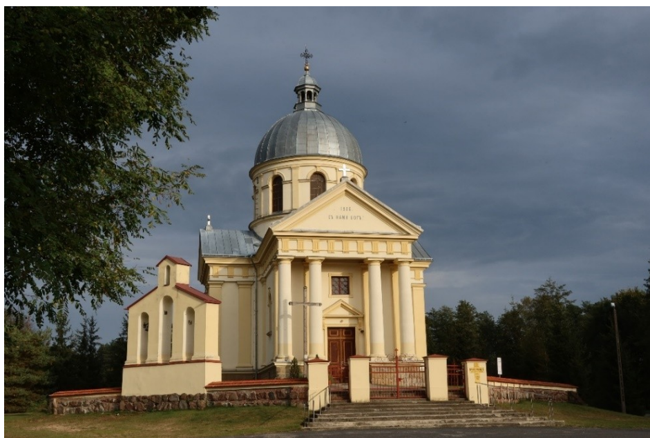
Dąbrownica, kościół po zakończeniu prac
