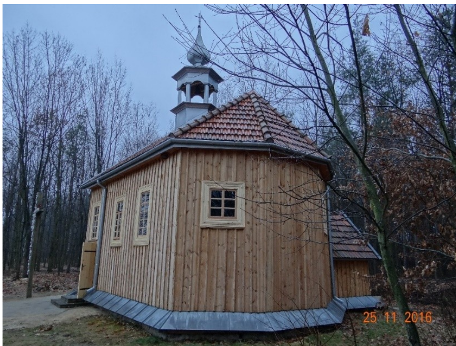
Dąbrownica, drewniana kaplica po zakończeniu prac
