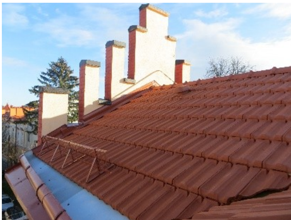
Ul. Kasprowicza 28, nowy dach
