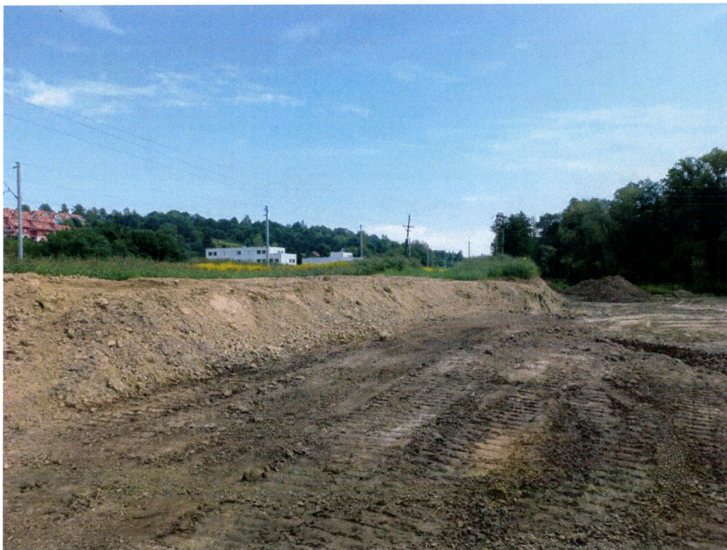
Foto. 9. Zbiornik Serafa 2, pierwsza dekada sierpnia 2022 r. (formowanie obwałowania zbiornika i kształtowanie czaszy zbiornika).
