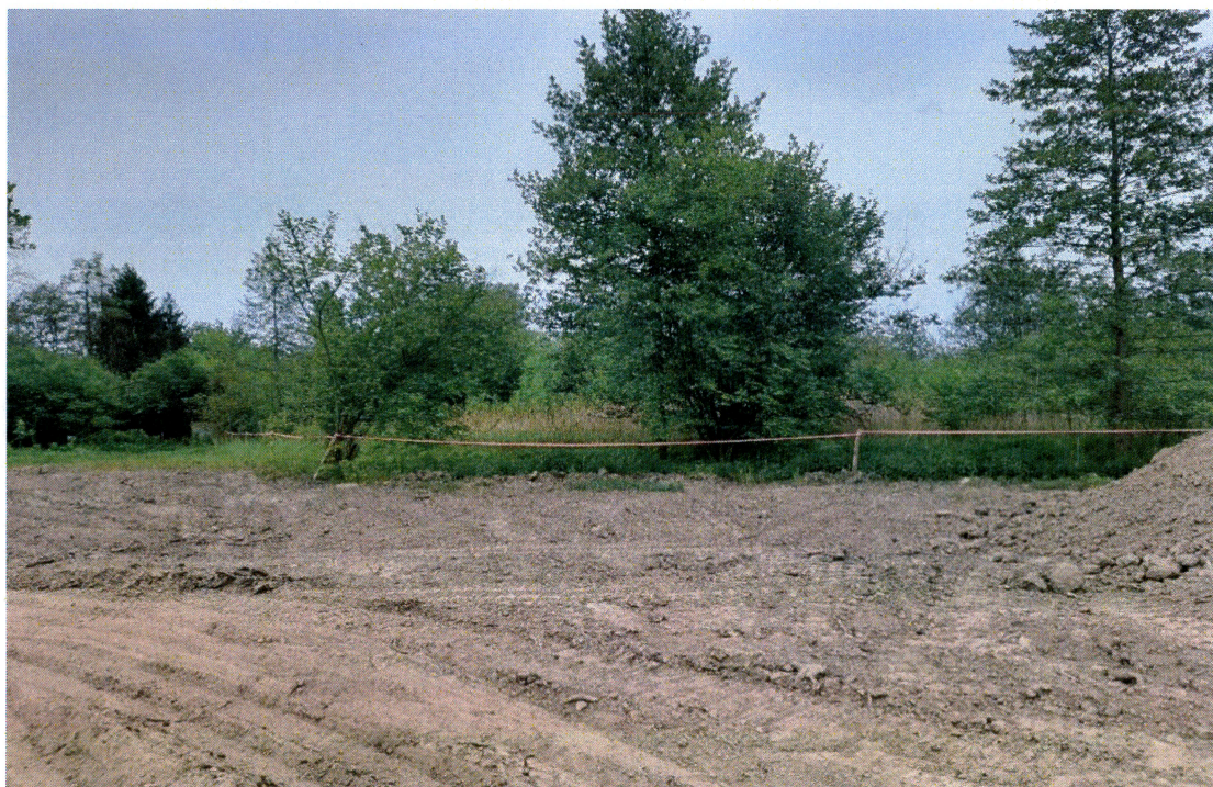
Foto. 7. Zbiornik Serafa 2, trzecia dekada maja 2022 r. (wygradzenie terenu poza placem budowy).
