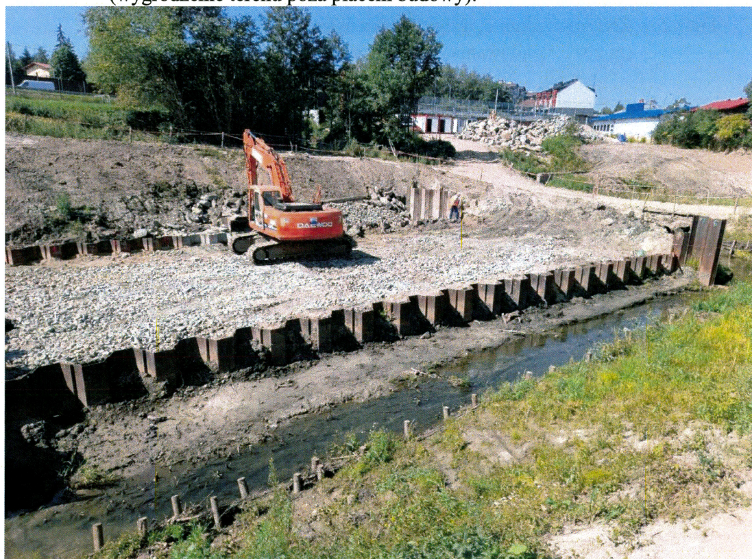
Foto. 8. Zbiornik Serafa 2, trzecia dekada lipca 2022 r. (budowa urządzenia upustowo-przelewowego, w tle wygradzenia).
