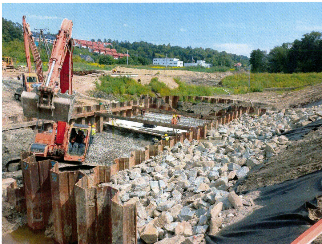
Foto. 10. Zbiornik Serafa 2, druga dekada sierpnia 2022 r. (budowa urządzenia przelewowo-spustowego).
