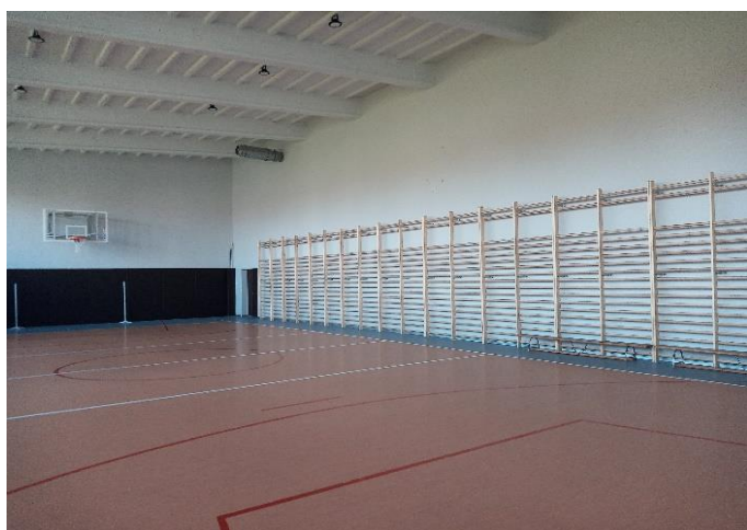
Sala gimnastyczna ZPO w Koniecznie po remoncie.
