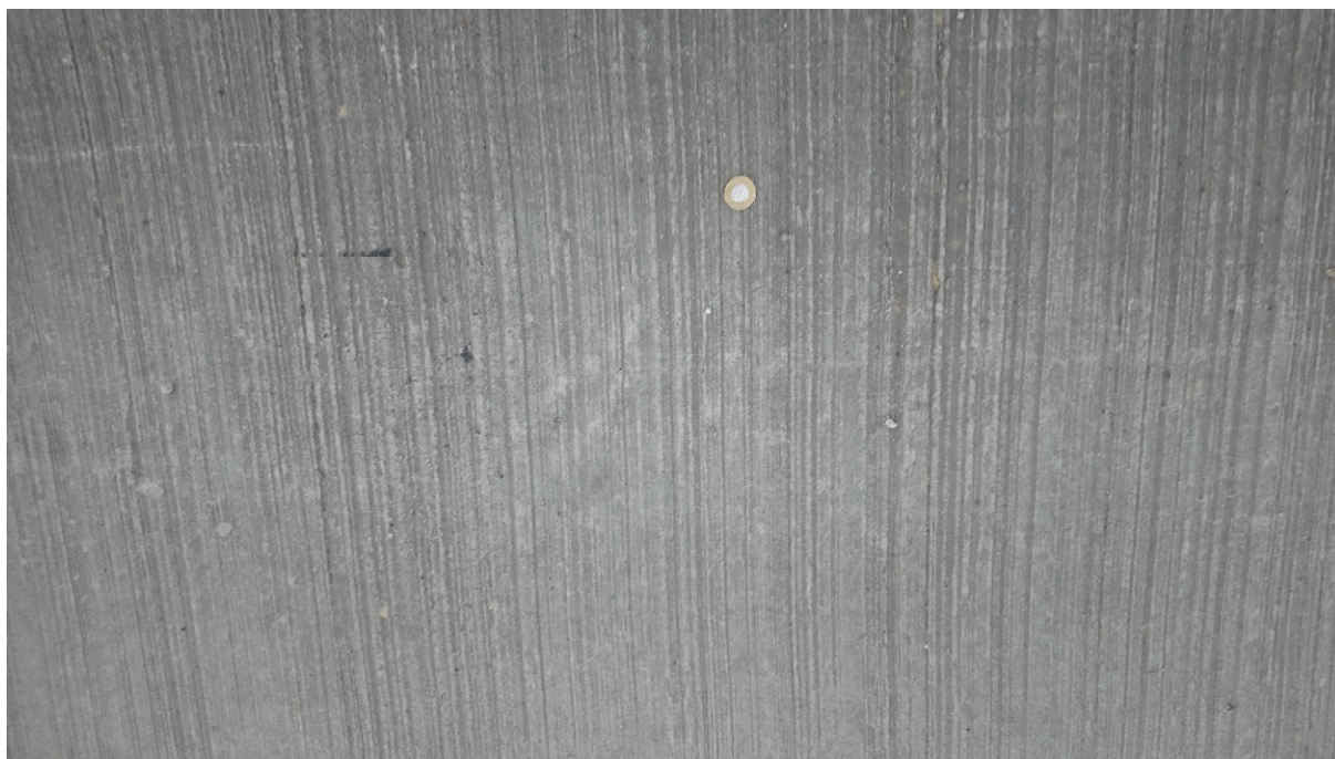
Rys. 1-10 Nawierzchnia CC poprzecznie rowkowana przy punkcie P5
