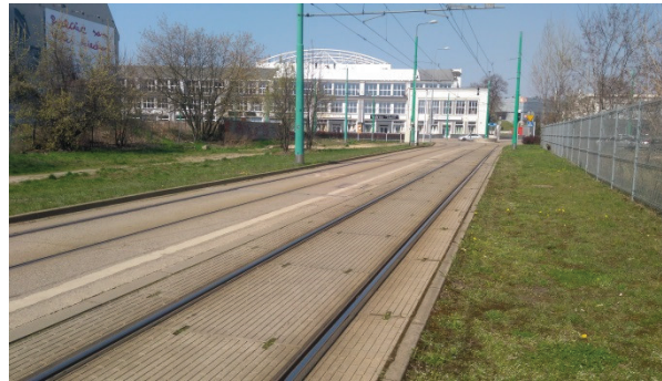
Rys. 3-89 Poligon badań hałasu tramwajowego na torowisku zabudowanym z szyną w otulinie tłumiącej hałas – rozstaw szyn 1435 mm (deskryptor torowiska CNOSSOS: TMNMNN)
