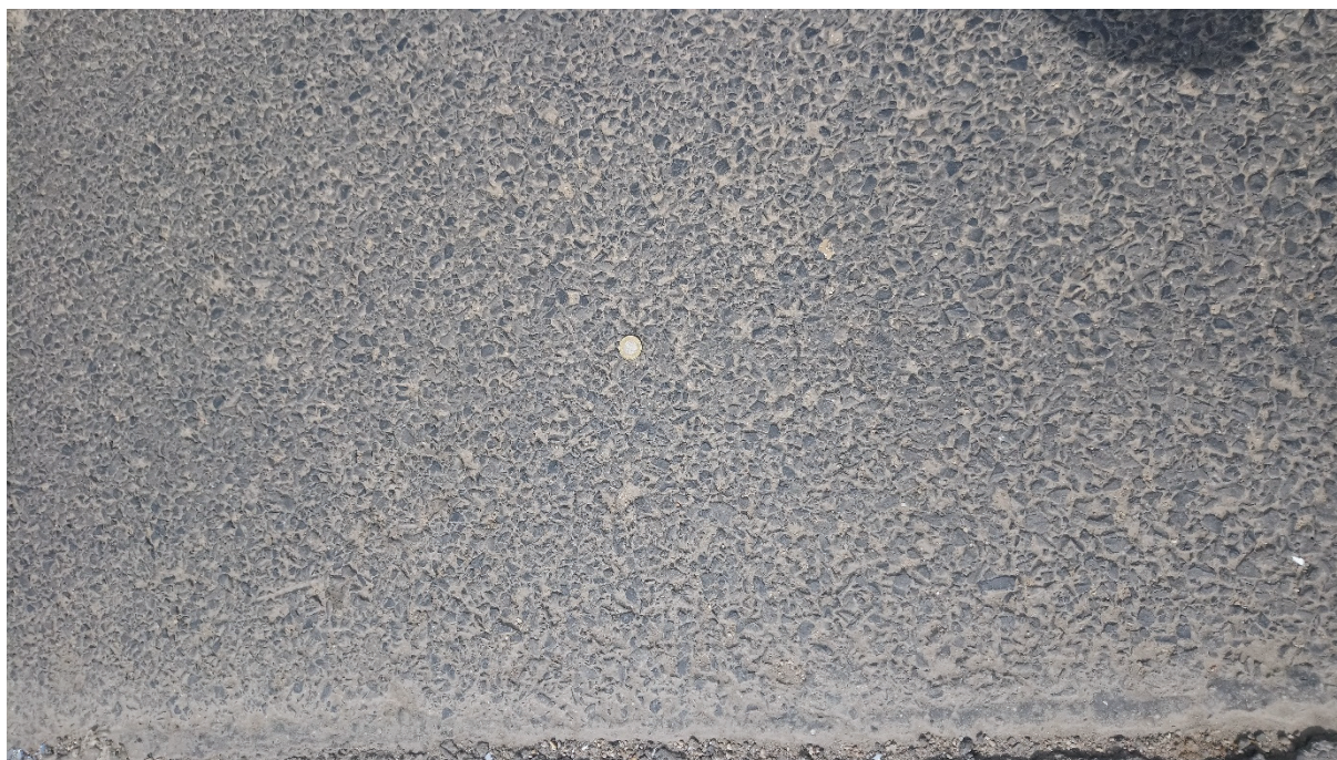
Rys. 1-6 Nawierzchnia SMA11 przy punkcie P3
