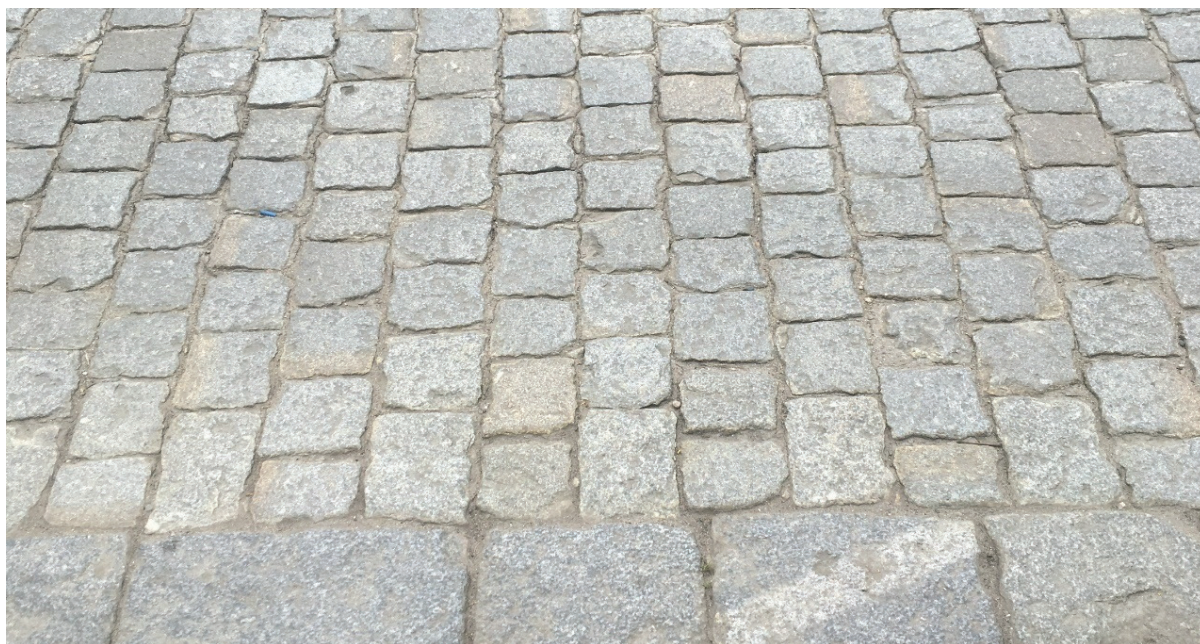
Rys. 1-14 Nawierzchnia SP granitowej przy punkcie P7
