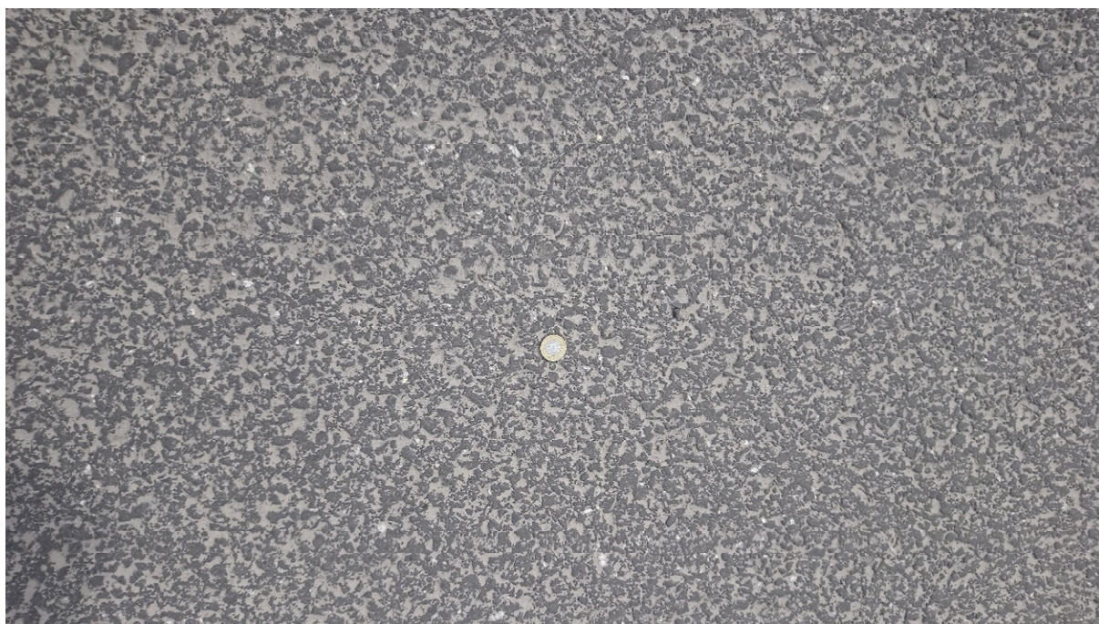
Rys. 1-4 Nawierzchnia SMA11 przy punkcie P2
