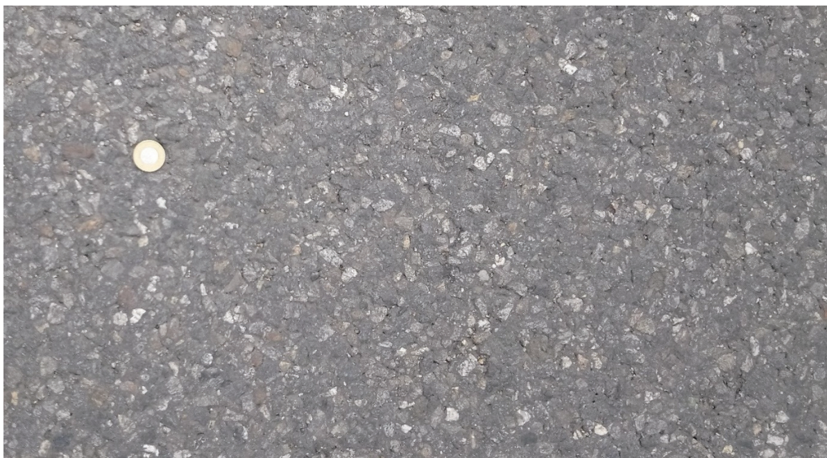
Rys. 1-2 Nawierzchnia SMA11 przy punkcie P1
