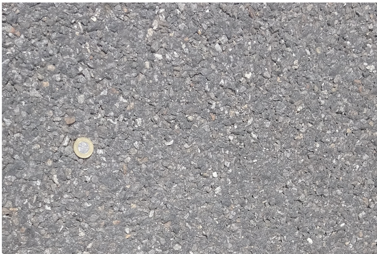
Rys. 1-8 Nawierzchnia SMA8 przy punkcie P4
