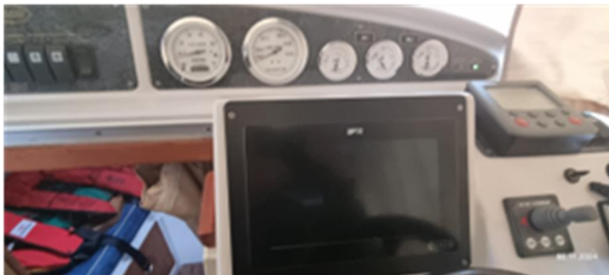
Foto nr 8 Łódź „KONTROLER -16” w Kątach Rybackich panel sterowniczy i wskaźników
