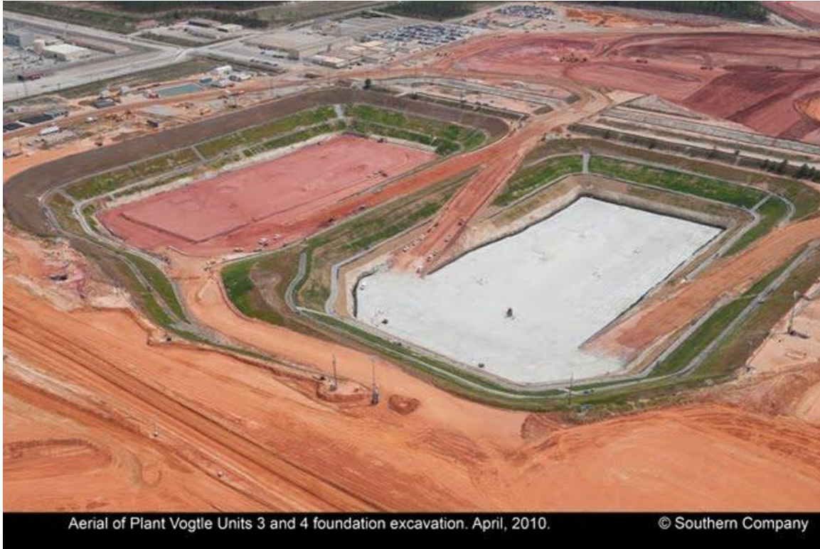
Wykop budowlany zabezpieczony chudym betonem
