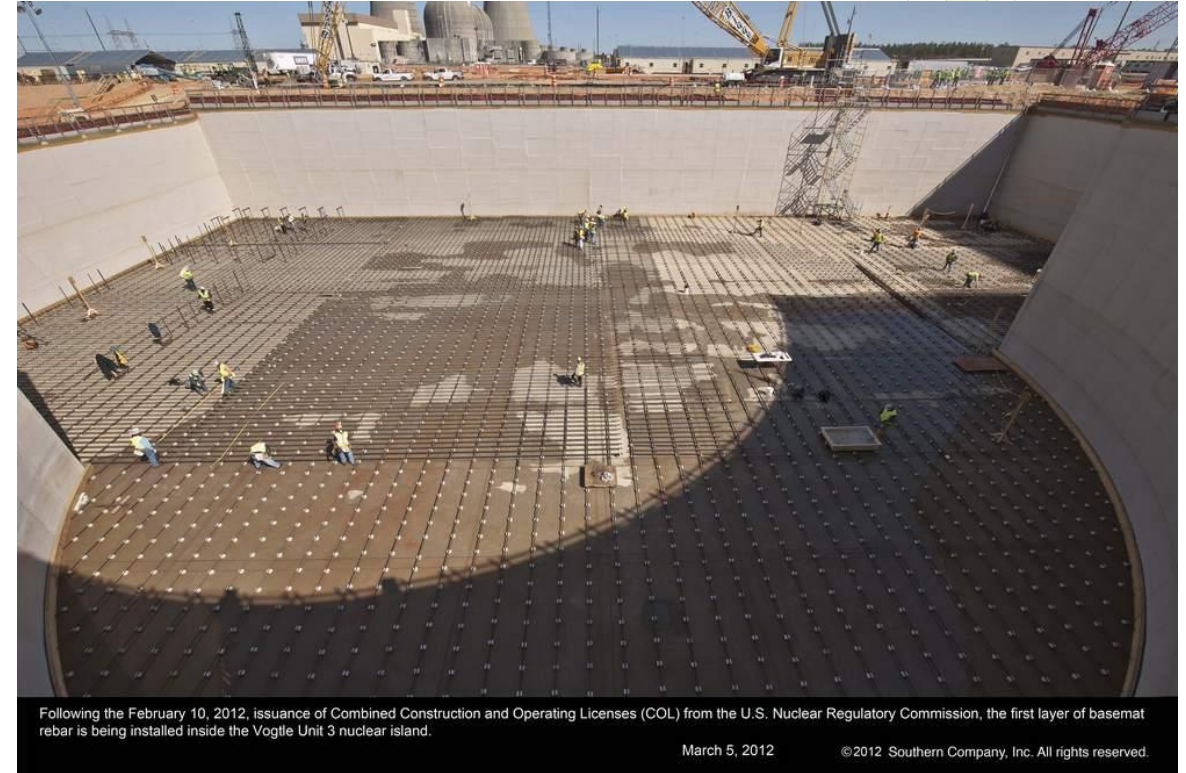
Wykonywanie zbrojenia płyty fundamentowej
