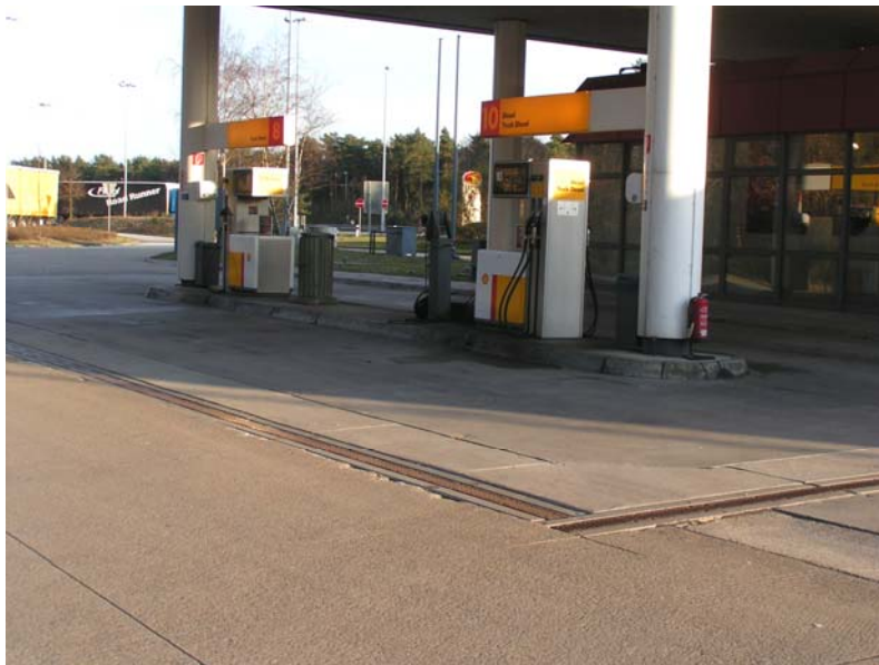
Rys. 2.6. Nawierzchnia szczelna stacji benzynowej na terenie MOP-u. Odwodnienie liniowe na krawędzi
