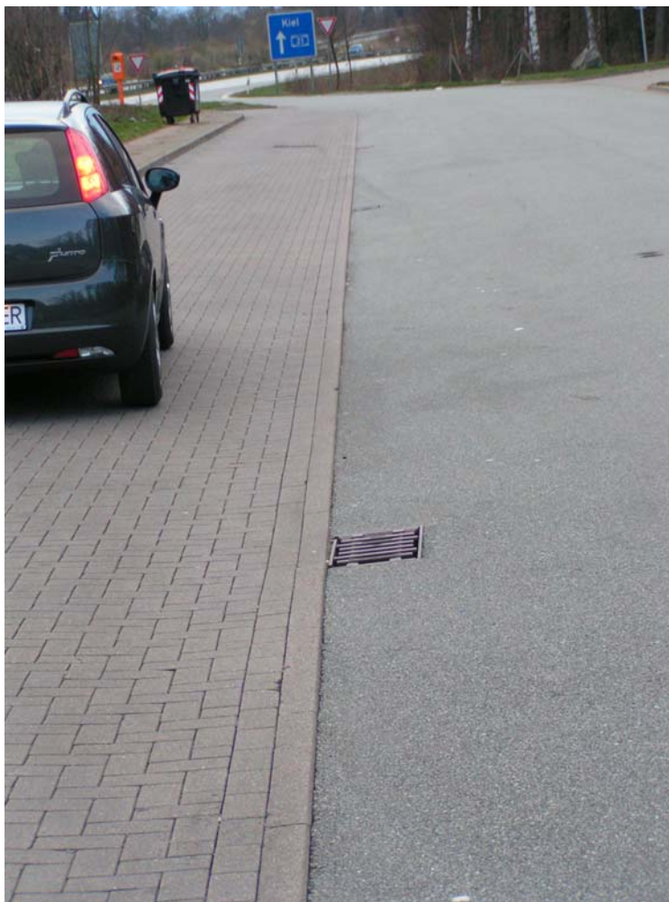
Rys. 4.7. Przykład wykonania ścieku przykrawężnikowego
