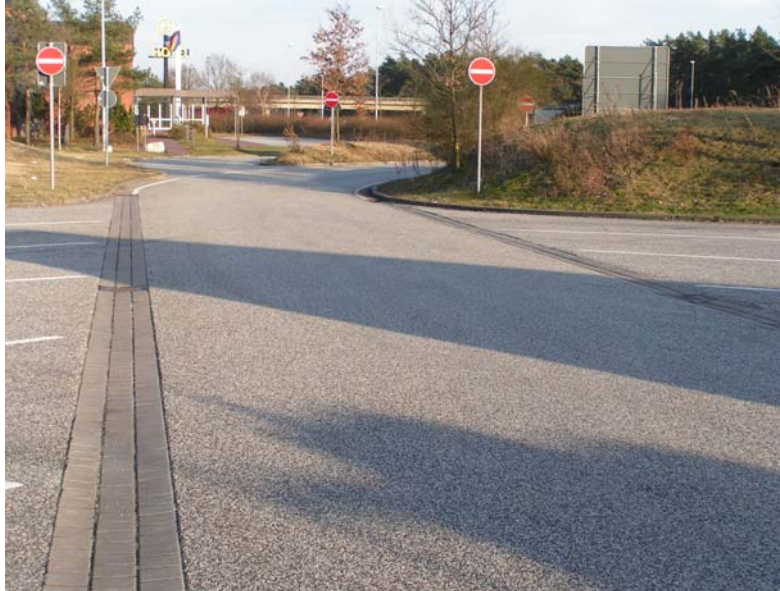
Rys. 2.5. Ściek z wpustem na krawędzi drogi manewrowej i miejsc postojowych
