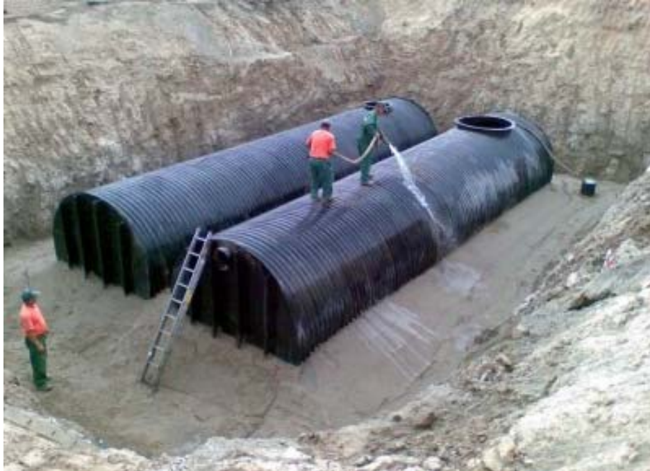
Rys. 4.21. Zbiornik retencyjny zamknięty [41]
