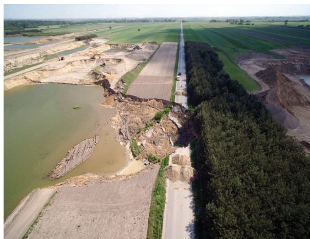
► Rys. 8. Osuwisko w ZG „Zastawie IV-2” [5]
