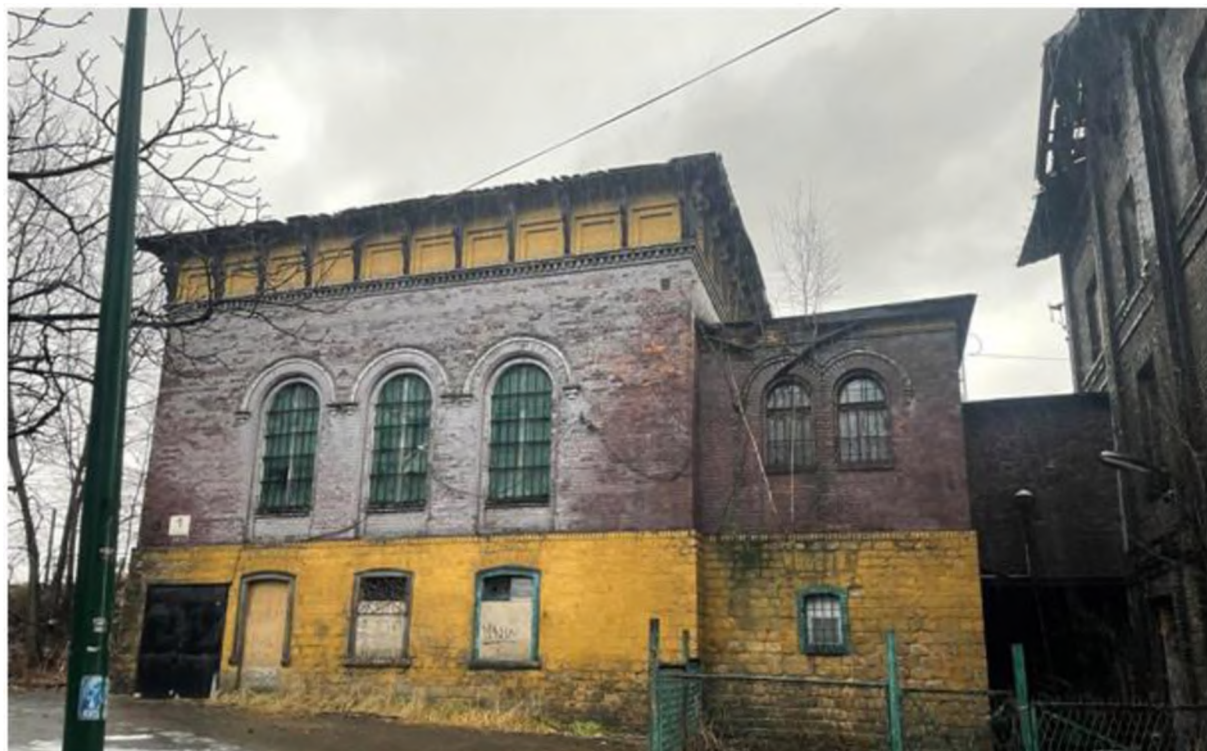
6. Zabytkowy budynek przy pl. Ogród Dworcowy 1A, stan na 24.01.2024 r.
