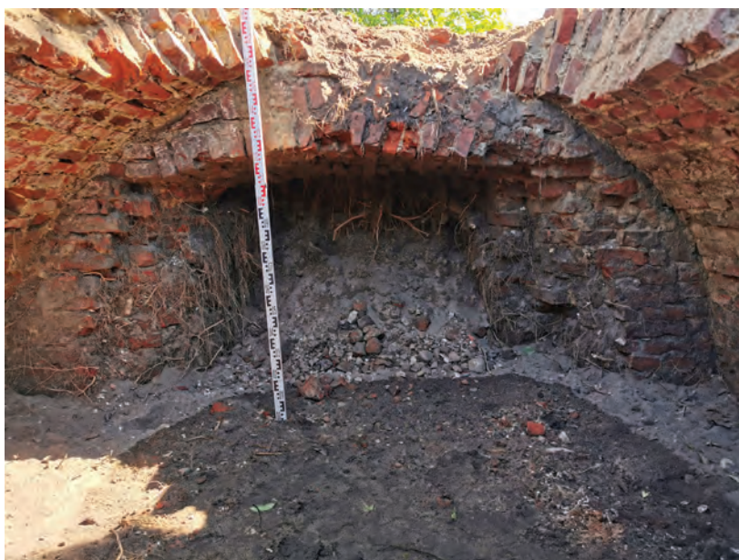
27. Zabłudów, pow. bialostocki. Wschodnia ściana piwnicy. Fot. L. Pawlata Zabłudów, East wall of the basement. Photo by L. Pawlata
