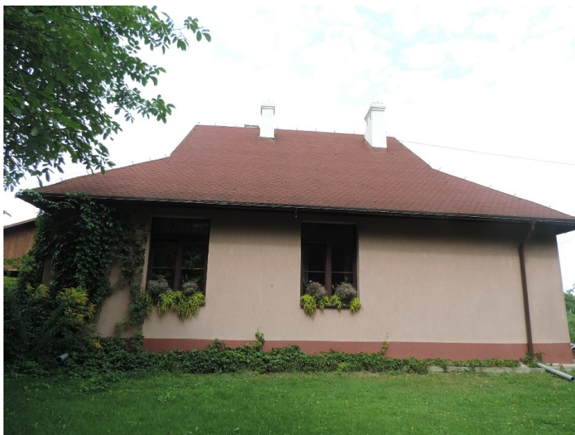
Foto Nr 1. - Elewacja frontowa budynku mieszkalnego leśniczówki Brzustów
