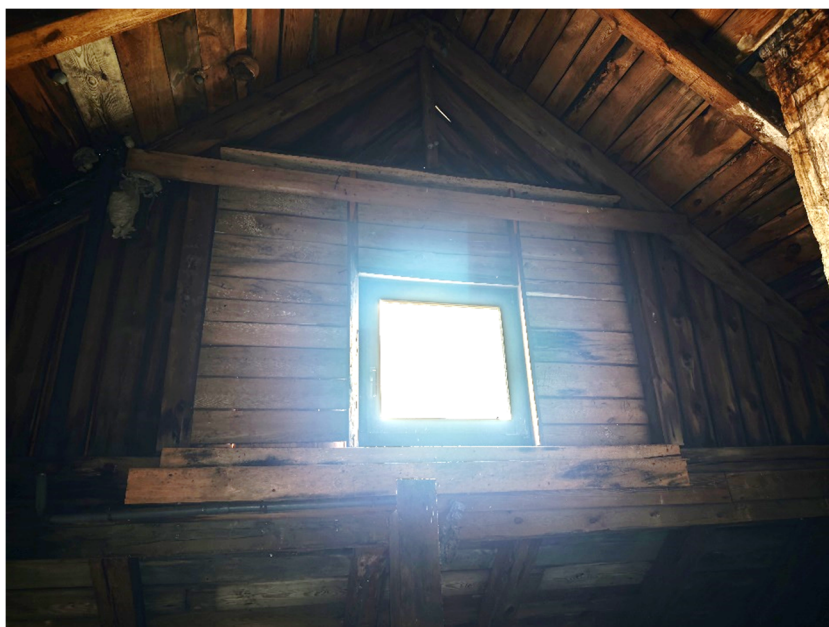
Foto Nr 8. – Ściana szczytowa Nr 1 od strony poddasza nieużytkowego
