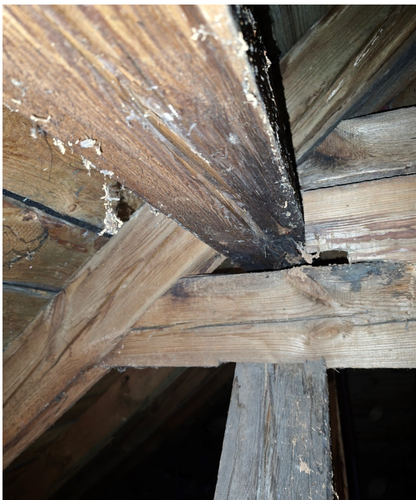
Foto Nr 11. – Połączenie słupa z płatwią i belką przy kominie Nr 4
