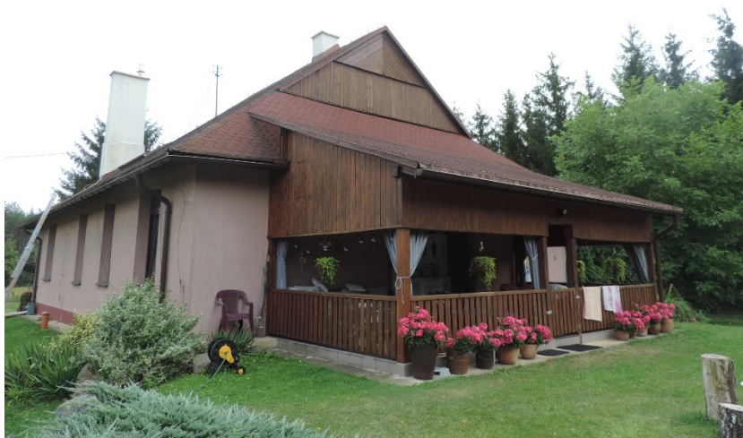
Foto Nr 4. - Elewacja boczna budynku mieszkalnego leśniczówki Brzustów
