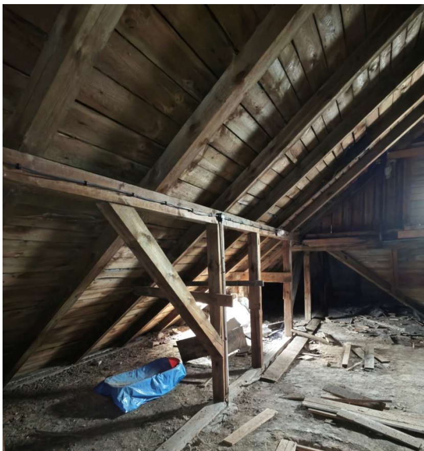
Foto Nr 6. - Obecny stan więźby dachowej
