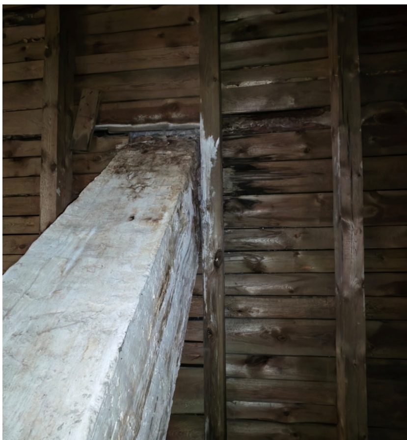
Foto Nr 9. - Stan deskowania przy kominie Nr 2
