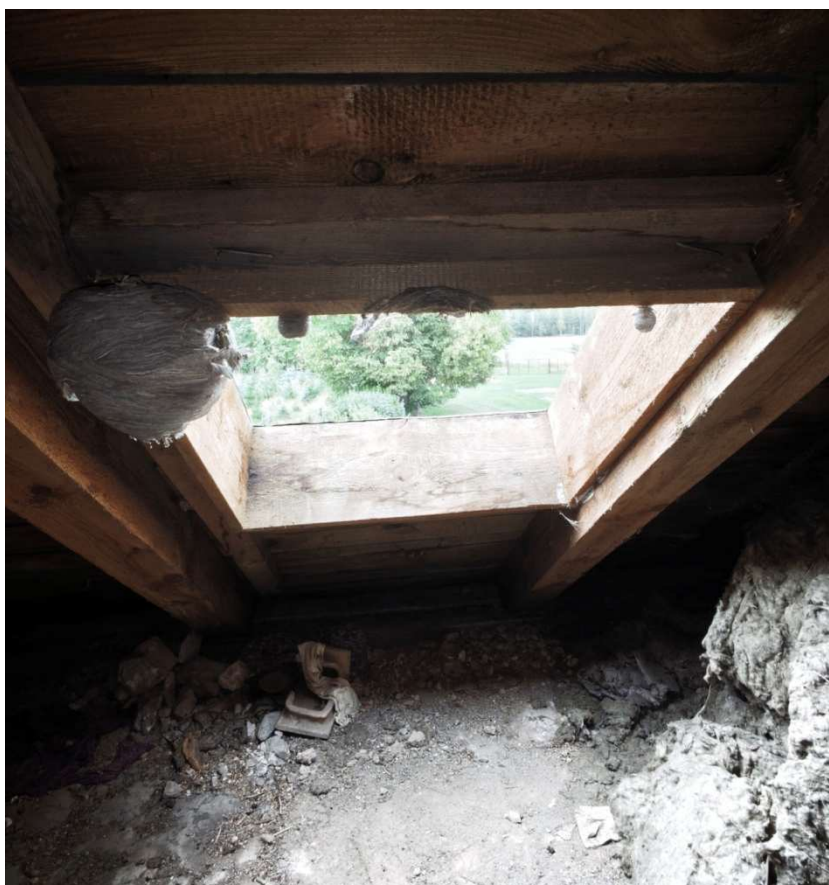
Foto Nr 10. - Istn. drewniany wyłaz dachowy
