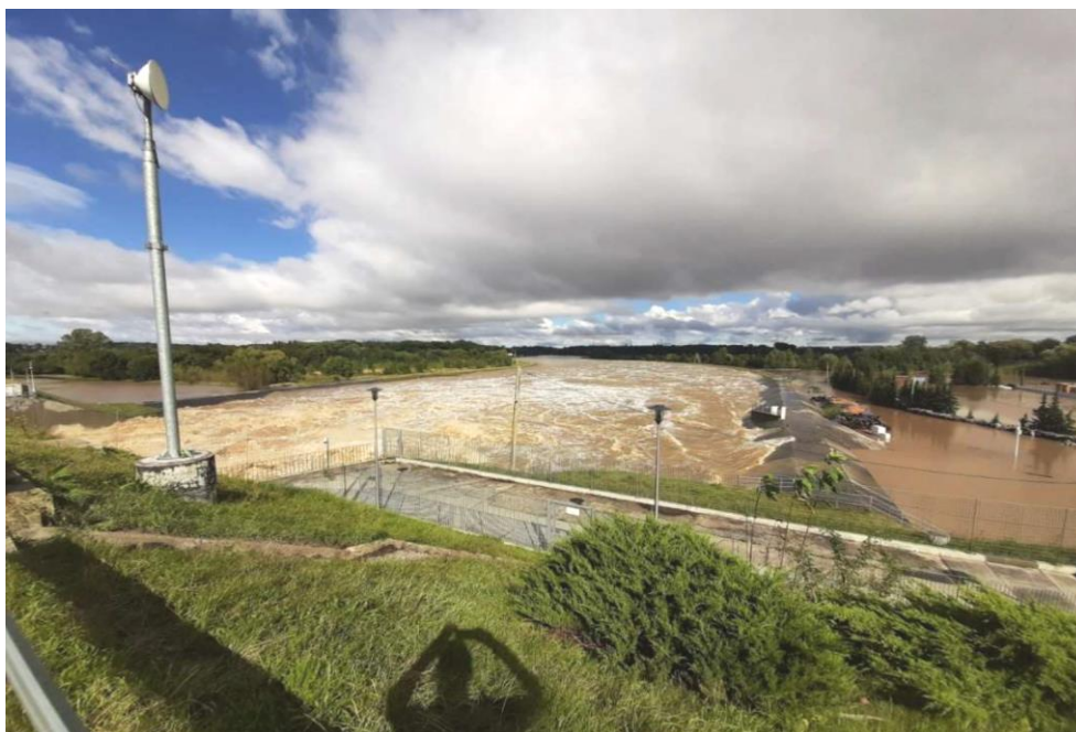
Rysunek 11.2.1 Widok na dolne stanowisko (2024-09-15) przy zrzucie Q = 800 \text{ m}^3/\text{s} – niesymetryczny zrzut wody przez segmenty budowli zrzutowej już przy tym odpływie powoduje falowanie sięgające góry ubezpieczeń
