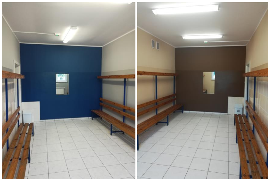
Zdjęcie nr 2. Wyremontowane szatnie zlokalizowane przy bloku sportowym w Zespole Szkół Gminy Kościan Przedszkole i Szkoła Podstawowa w Starych Oborzyskach
