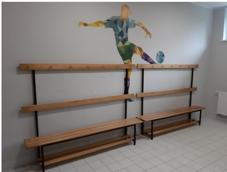
Zdjęcie nr 1. Wyremontowane szatnie przy dużej sali gimnastycznej w Szkole Podstawowej im. Konstytucji 3 Maja w Śmiglu
