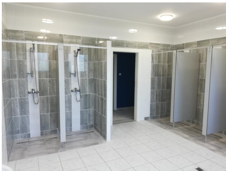
Zdjęcie nr 5. Wyremontowane natryskownie zlokalizowane przy bloku sportowym w Zespole Szkół Gminy Kościan Przedszkole i Szkoła Podstawowa w Starych Oborzyskach
