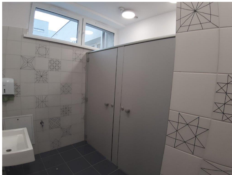
Zdjęcie nr 4. Wyremontowane pomieszczenia sanitarne bloku sportowego w Szkole Podstawowej im. Konstytucji 3 Maja w Śmiglu
