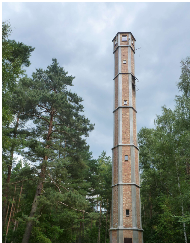
Zdjęcie 2. DOSTRZEGALNIA PRZECIWOŻAROWA Z UMIESZCZONĄ NA WIERZCHOŁKU KAMERĄ.
