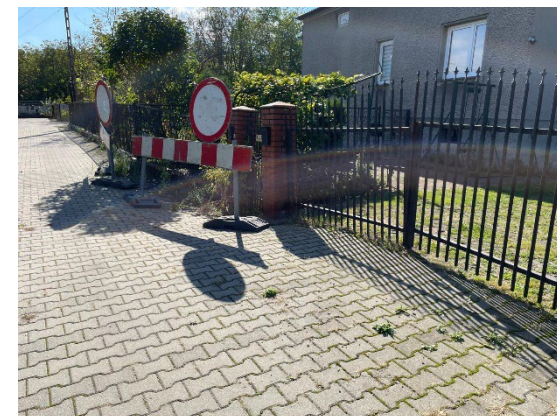
Lej w miejscu starego szybu górniczego w Będzinie ul. Świerkowa (2024 r.)
