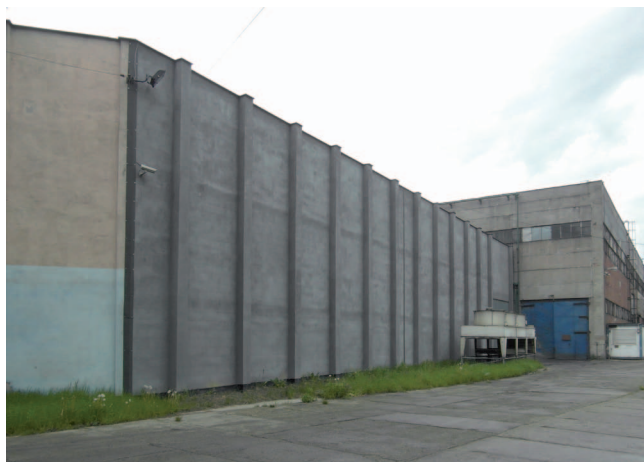
Fot. 4. Metalpol, Węgierska Górka - wybudowanie ekranu dźwiękochłonnego w postaci ściany murowanej, zapewniającego zasłonięcie zespołu chłodni wentylatorowych
