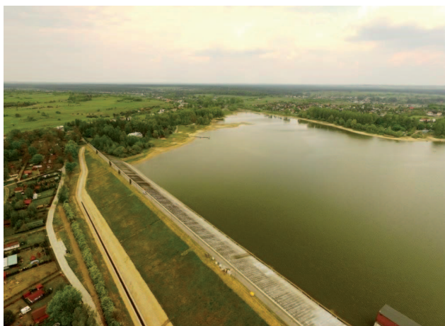
Fot. 7. Widok na zbiornik Przeczyce od strony korony zapory
