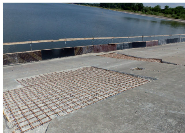
Fot. 9. Reprofilacja powierzchni betonowych
