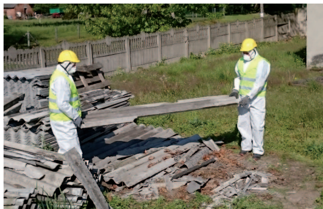
Fot. 10. Prace związane z usuwaniem azbestu
